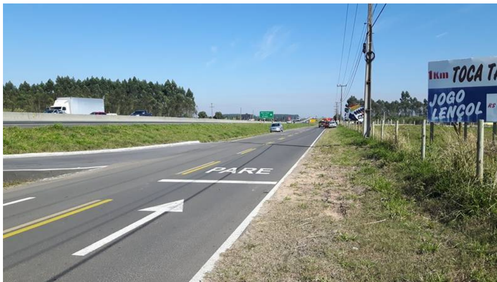
Figura 03 – Vista do local no sentido crescente (sentido do Fiat Uno), via marginal.
