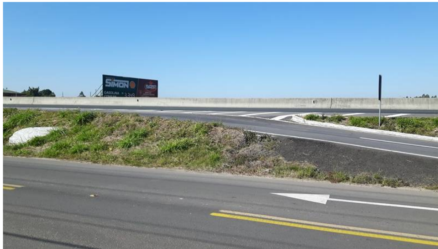
Figura 04 – Vista do local – agulha de saída utilizada pelo veículo 01.
