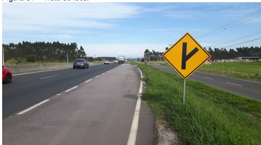
Figura 01 – Vista do local
