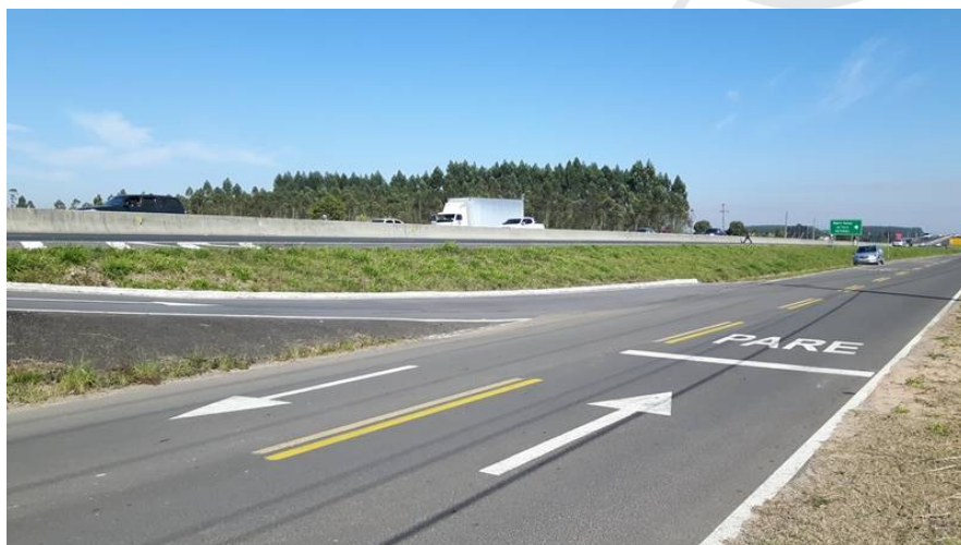
Figura 06 – Vista do local – agulha de saída utilizada pelo veículo 01.
