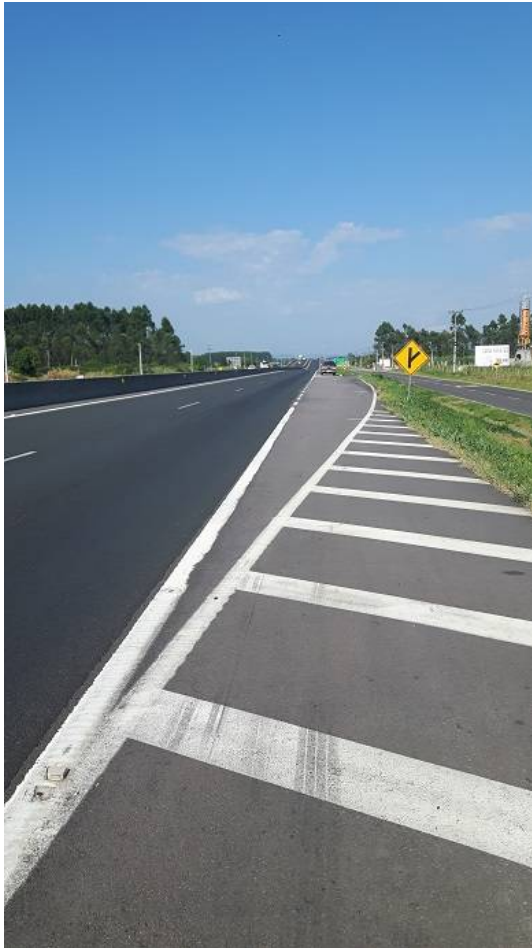
Figura 01 – Vista do local no sentido crescente (sentido do Fiat Uno), pista principal.
