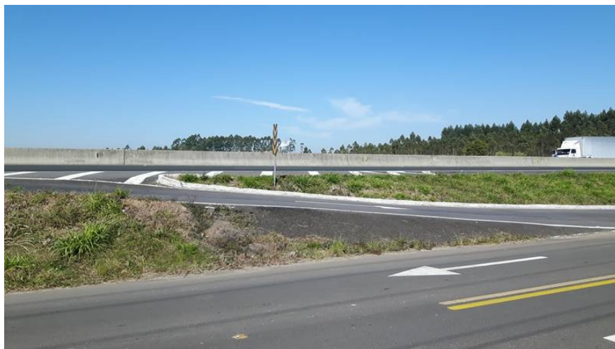
Figura 05 – Vista do local – agulha de saída utilizada pelo veículo 01.
