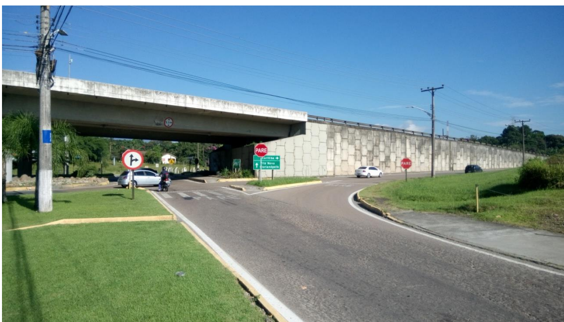
Figura 6 – Entrada da rótula, rua XV de Novembro, sentido bairro
