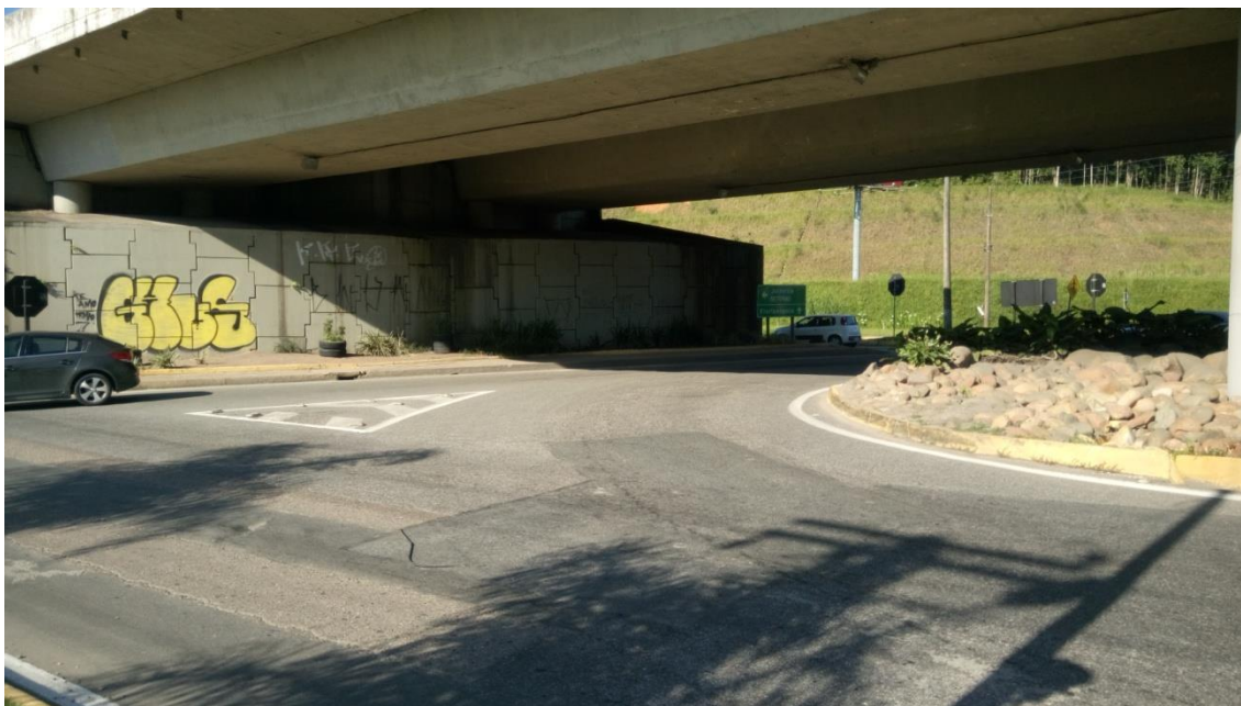
Figura 9 – Vista parcial da rótula, sentido centro
