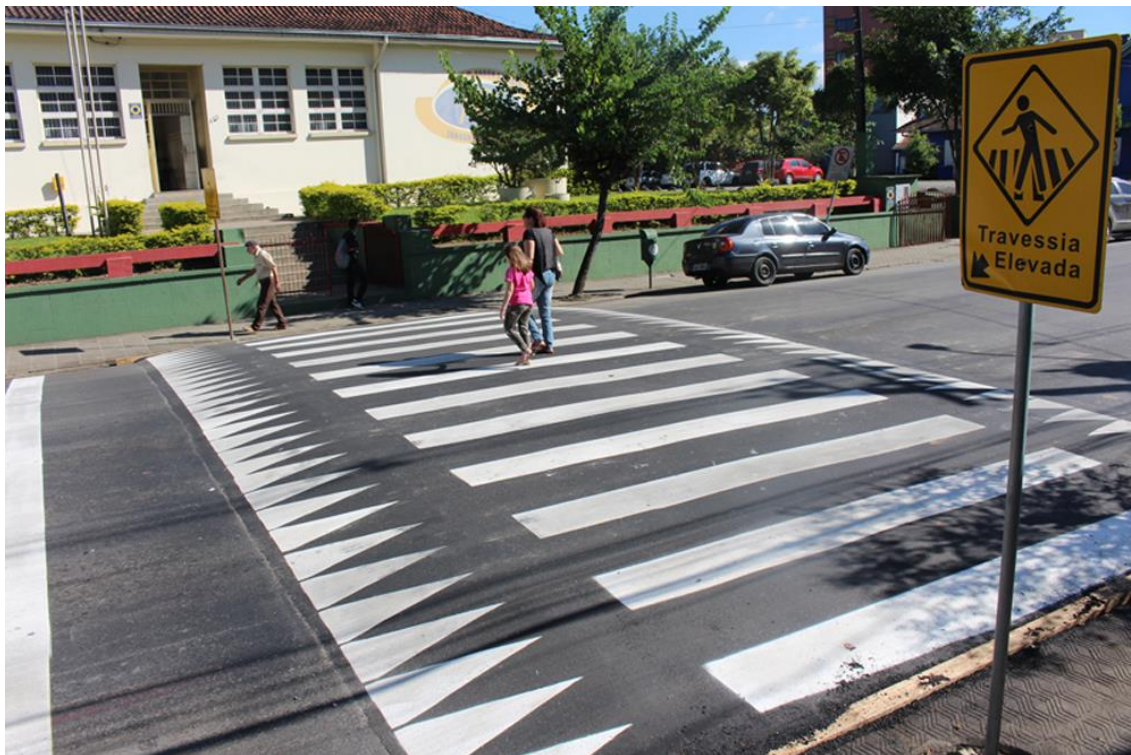
Figura 12 – Faixa elevada para travessia de pedestres
