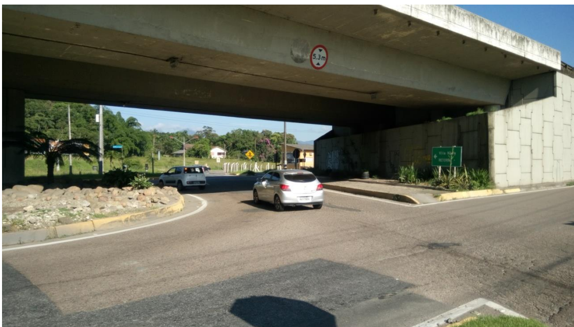
Figura 8 – Vista parcial da rótula, sentido bairro
