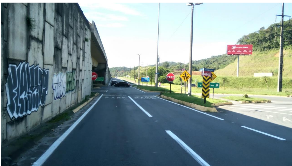
Figura 5 – Entrada da rótula, marginal sentido Florianópolis
