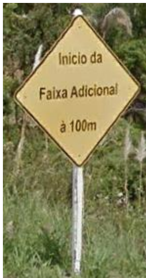
Figura 25 - Placa não classificada - tipo advertência sem sinal interno, contendo em seu lugar a inscrição “Início da Faixa Adicional à 100m”
