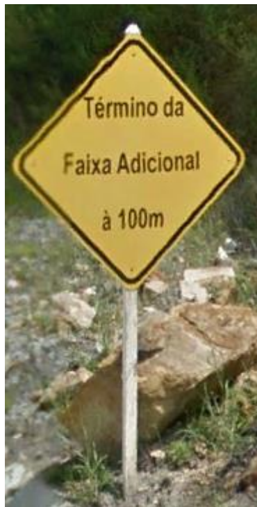
Figura 26 - Placa não classificada - tipo advertência sem sinal interno, contendo em seu lugar a inscrição “Término da Faixa Adicional à 100m”
