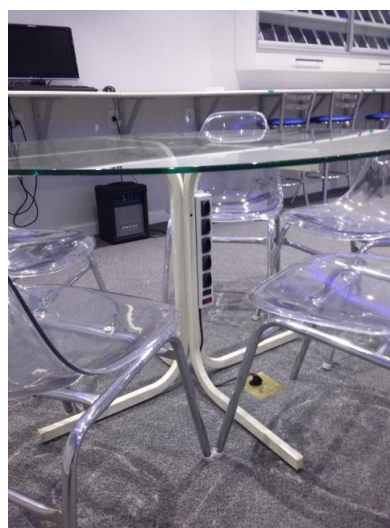
Figura 5 - Mesas com conexões elétricas. (fotografado em 16/05/17).
