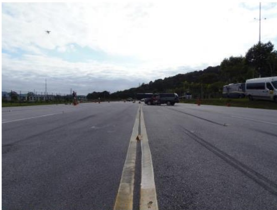
Figura 1: Visão panorâmica da rodovia BR 116, quilômetro 145.
