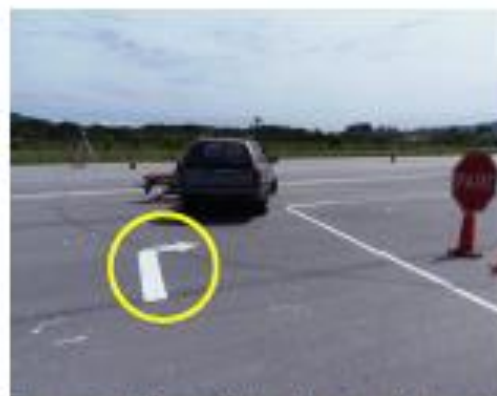
Figura 6: Sinalização horizontal orientando virar à direita após a parada obrigatória.
