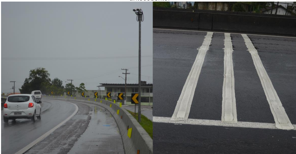
Figura 18 – Fiscalização eletrônica de velocidade e alerta sonoro antecedente.
