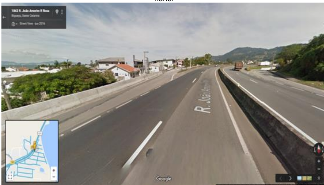
Figura 1 – Visão da rodovia, leito no sentido decrescente, saída da curva acentuada para o norte.
