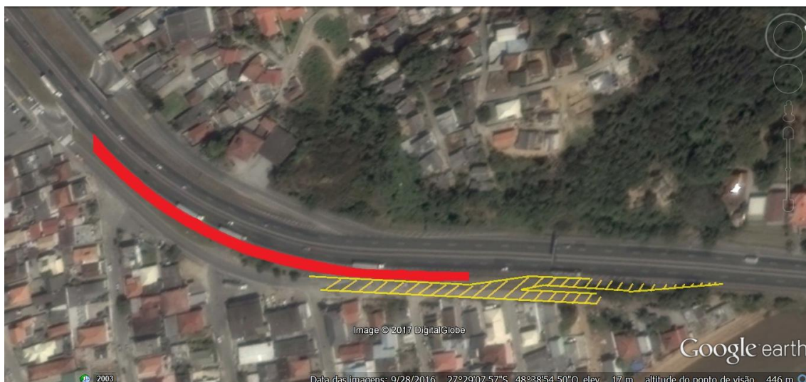
Figura 20 – Vista aérea com marcação das áreas para melhorias.
