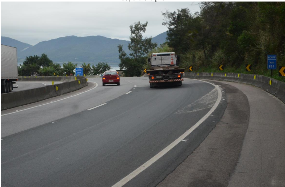
Figura 10 – Curva no Km 191 da BR-101, sentido norte, com superlargura e superelevação.
