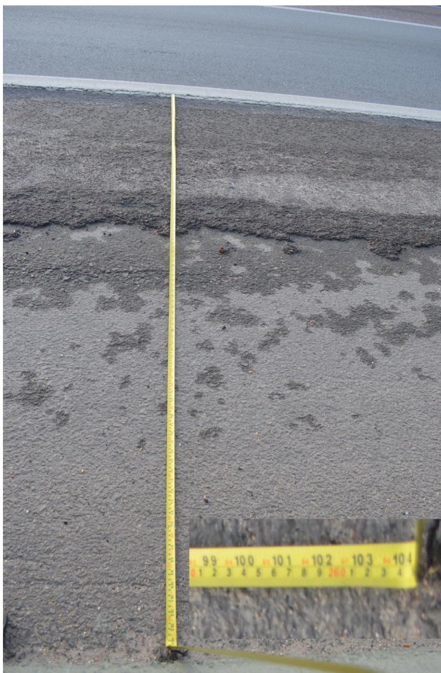
Figura 5 – Medição da largura do acostamento, Km 192 da BR-101.
