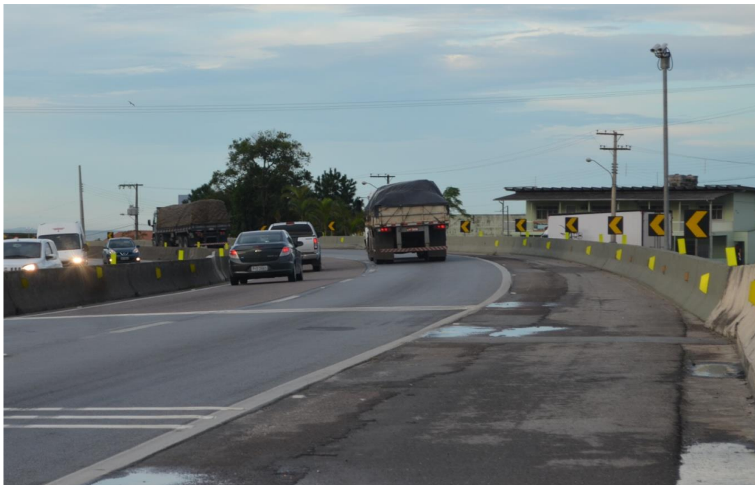
Figura 3 – Km 192 da BR-101, visão da rodovia, leito no sentido decrescente, curva acentuada para esquerda, sentido norte.
