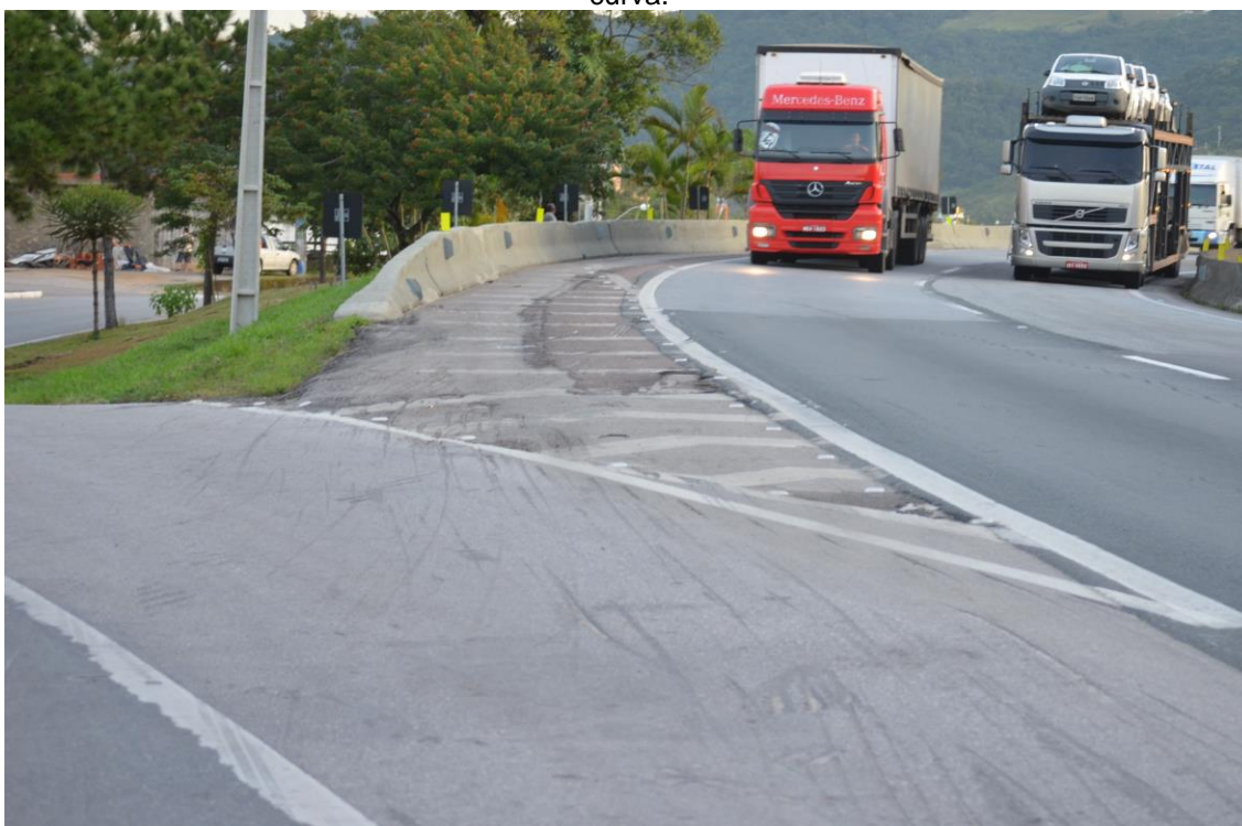
Figura 16 – Acesso a BR-101, marcas no asfalto de tombamentos/capotamentos no final da curva.
