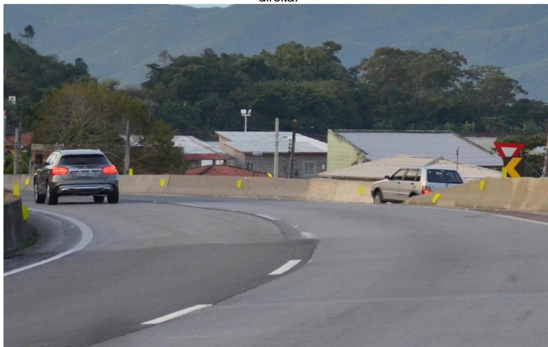
Figura 15 – Curva Km 192, acesso a BR-101 no final da curva. Acentuando a declividade a direita.
