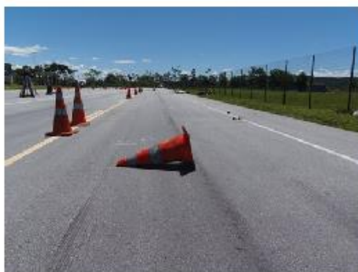
Figura 6 – Cone sobre a faixa de trânsito
