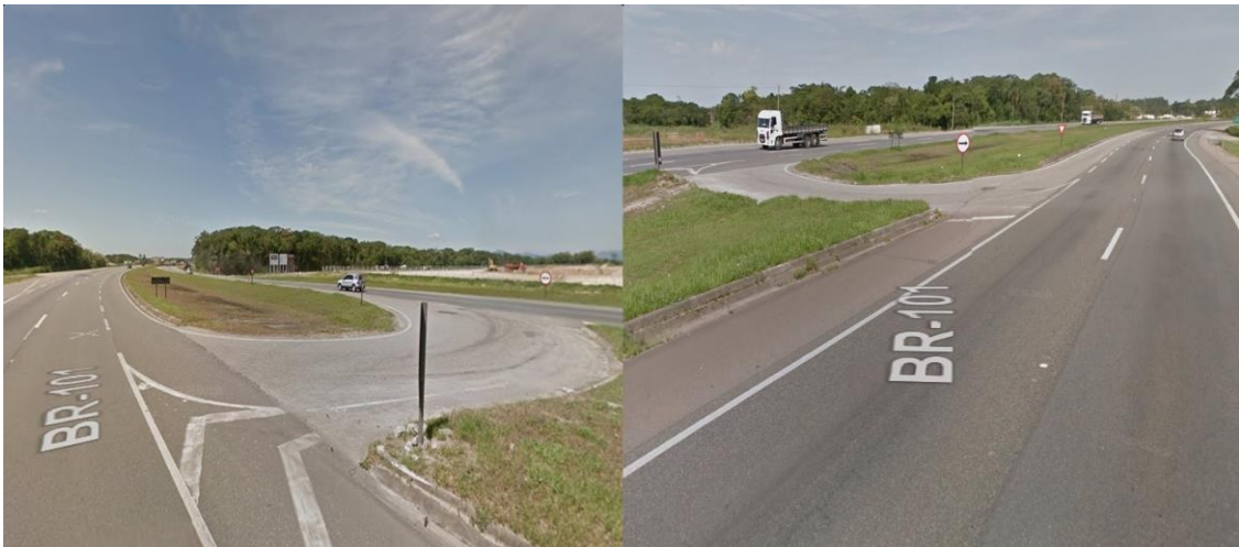
Figura 7 – Faixas de mudança de velocidade
