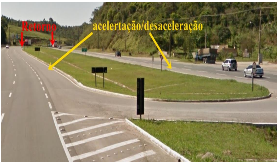
Figura 19 – Faixas de mudança de velocidade no km 97
