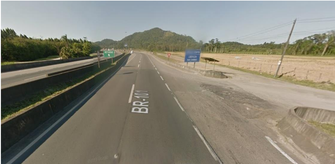
Figura 16 – Acostamento no km 79,8
