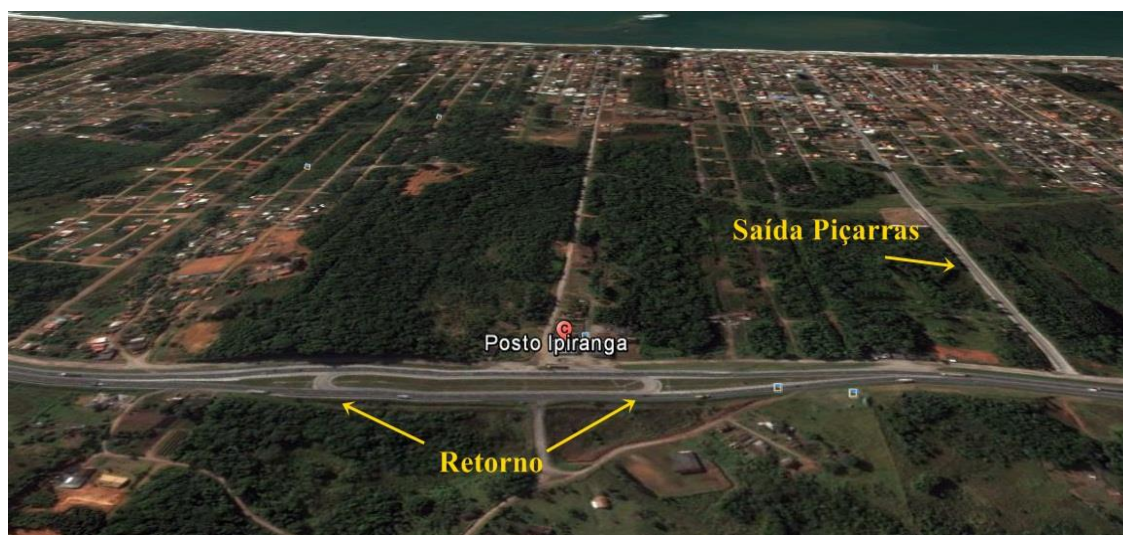
Figura 20 – Construções nas proximidades do km 97
