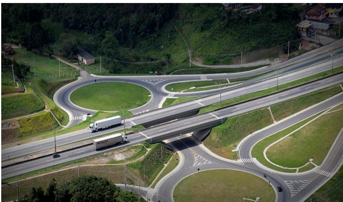
Figura 4 – Retorno em desnível
