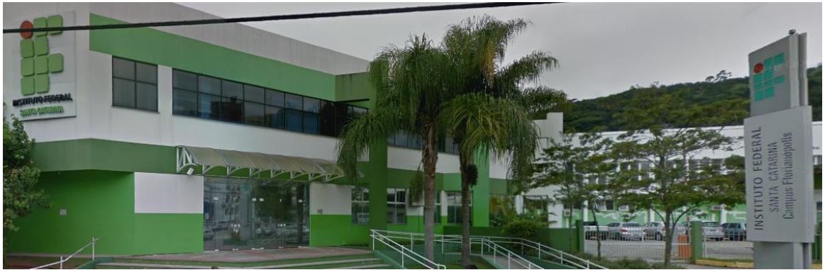
Figura 6 – Fachada IFSC campus Florianópolis.
