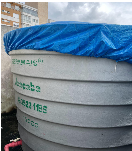
Figura 20 - Caixa d'água potável existente
