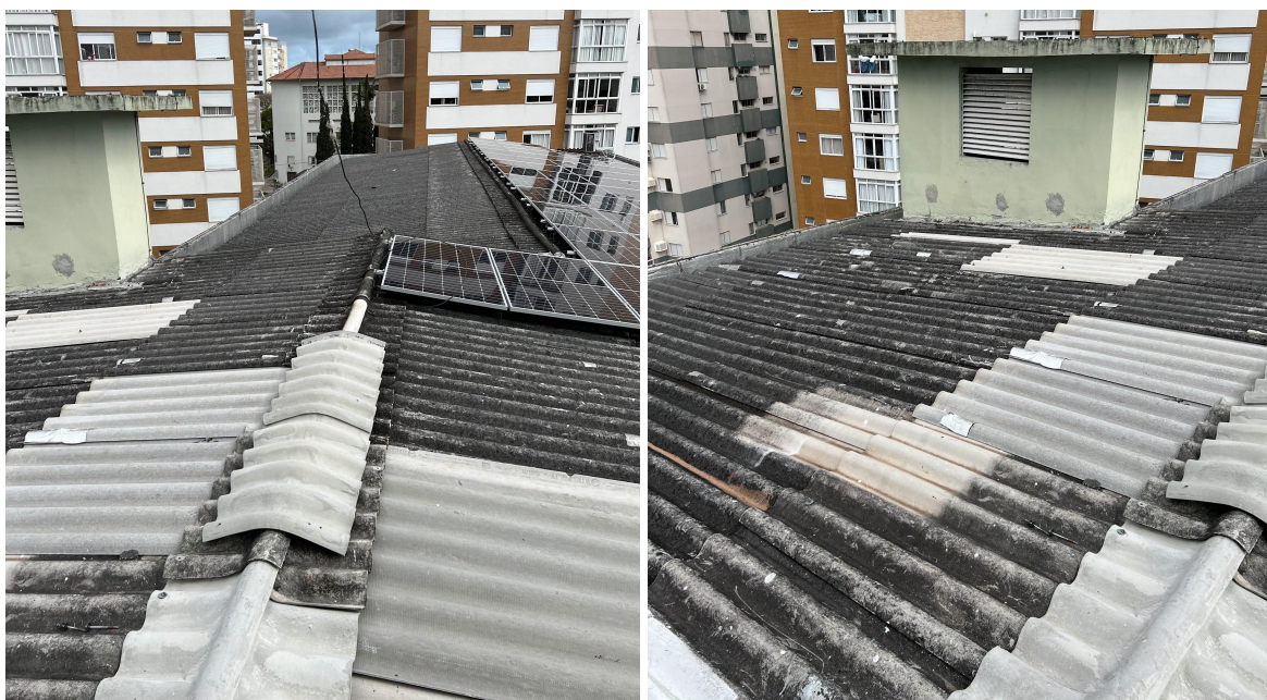
Figuras 22 e 23 - Vista da cobertura da instituição
