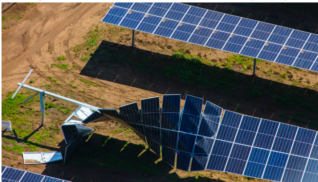
Figura 3 – Danos estruturais causados por torsional galloping .
