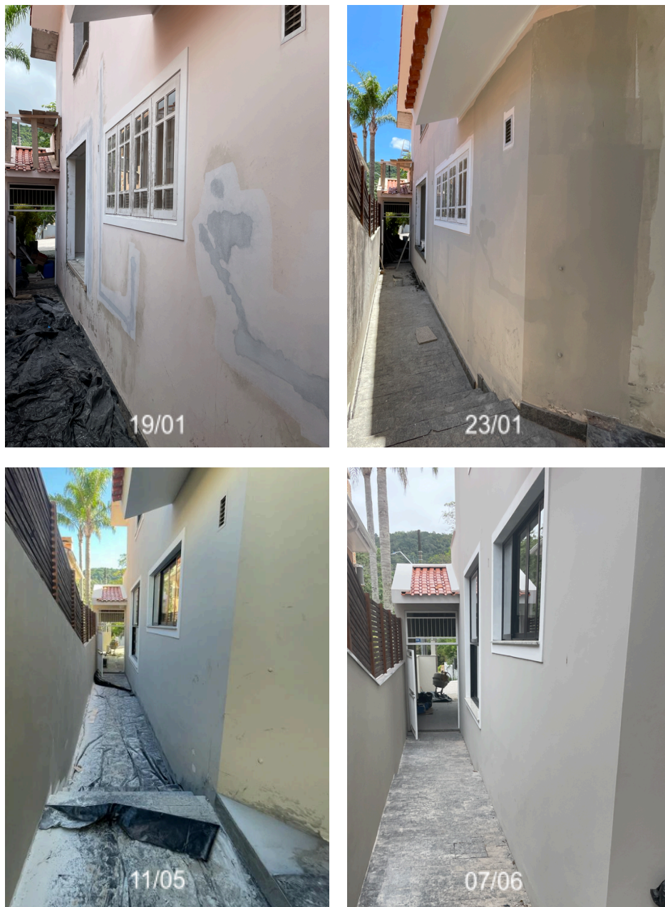
Figura 11 – Fotografias de Falta de Terminalidade na Pintura
