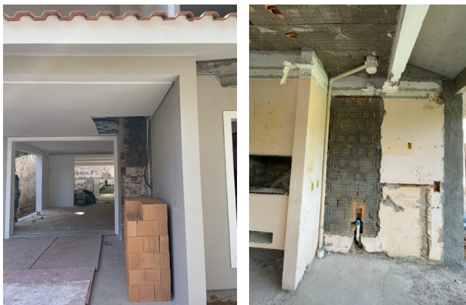
Figura 17 – Esquerda: Falta de Terminalidade | Direita: Retrabalho
