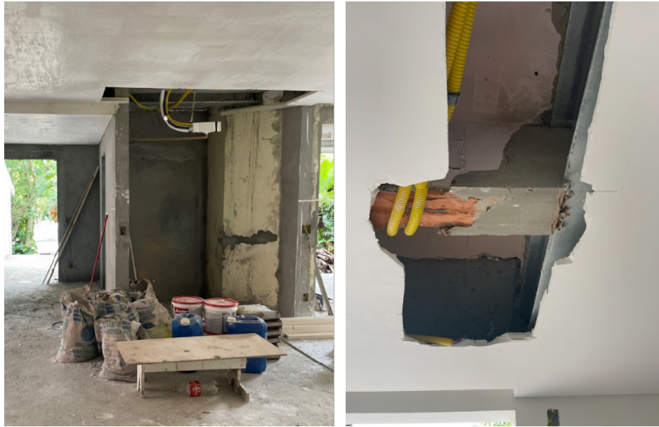
Figura 16 – Exemplo de perda no revestimento por tarefa anterior
