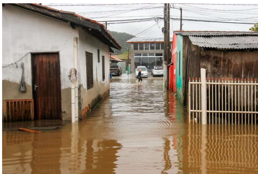
Figura 6 – Residências locais atingidas por eventos de inundação periódica no Rio Tavares
