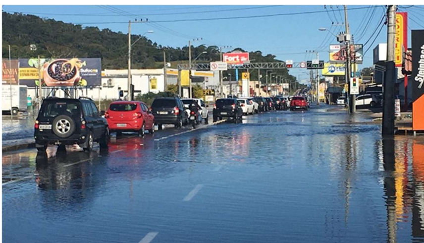
Figura 33 – Alagamento na SC-405
