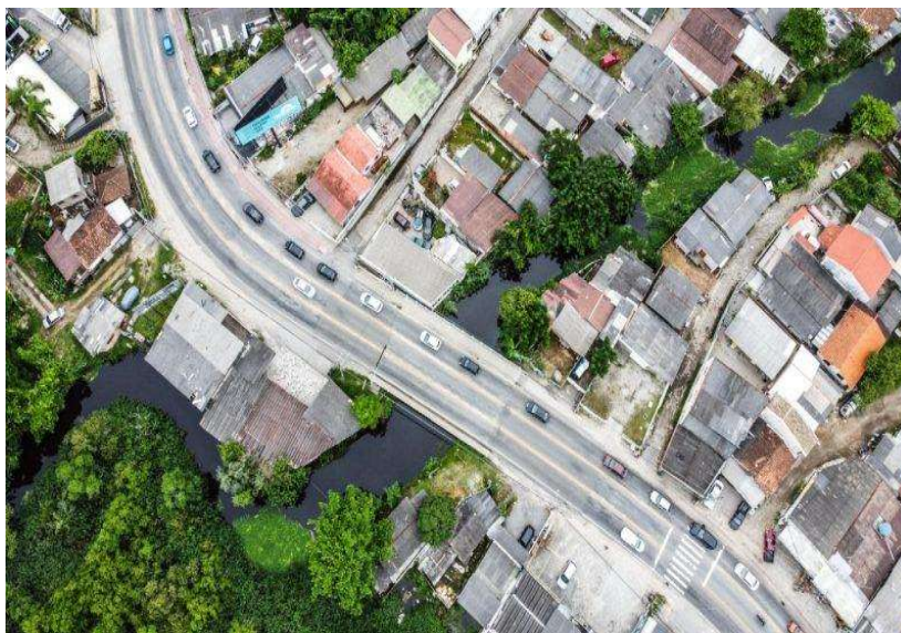
Figura 31 - Residências construídas nas margens do Rio Tavares
