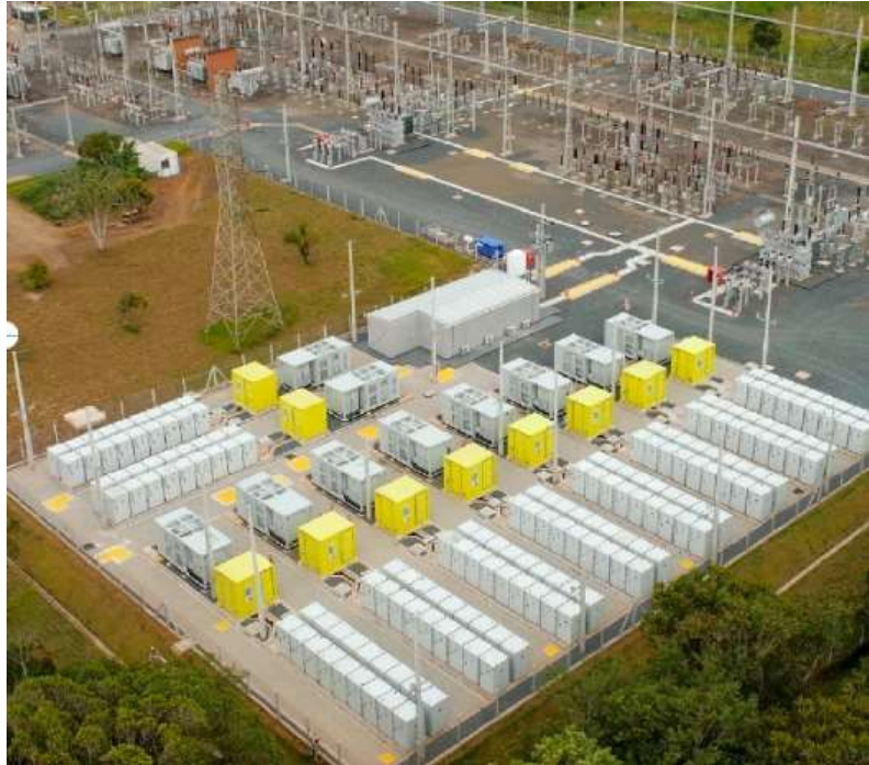
Figura 14 - Sistema de armazenamento de energia na subestação de Registro/SP
