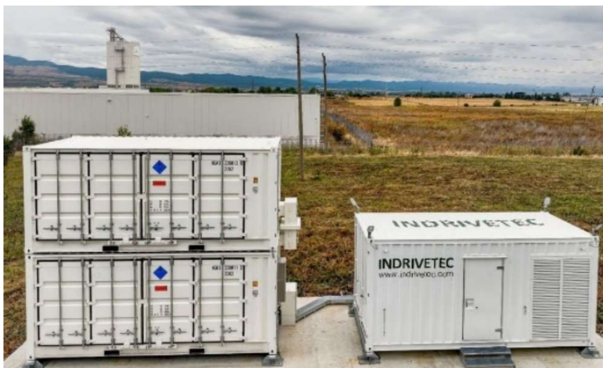
Figura 15 - Baterias de enxofre-sódio da NGKilits na Europa Oriental em operação na Bulgária
