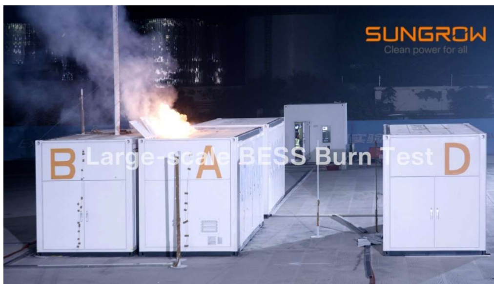
Figura 34 - Sungrow, teste de incêndio
