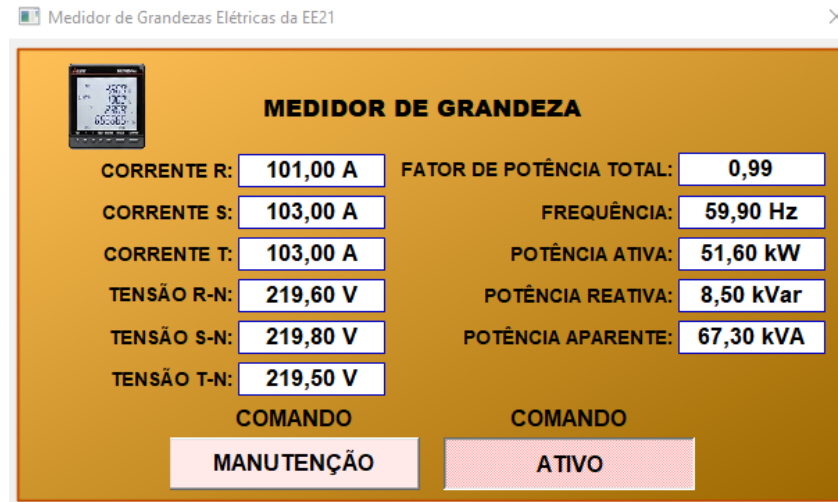
Figura 18 – Janela do MGE da EEE 21 no sistema supervisório do SEMASA Itajaí
