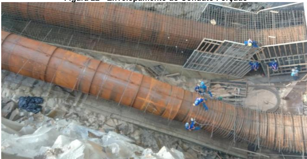
Figura 22 - Envelopamento do Conduto Forçado
