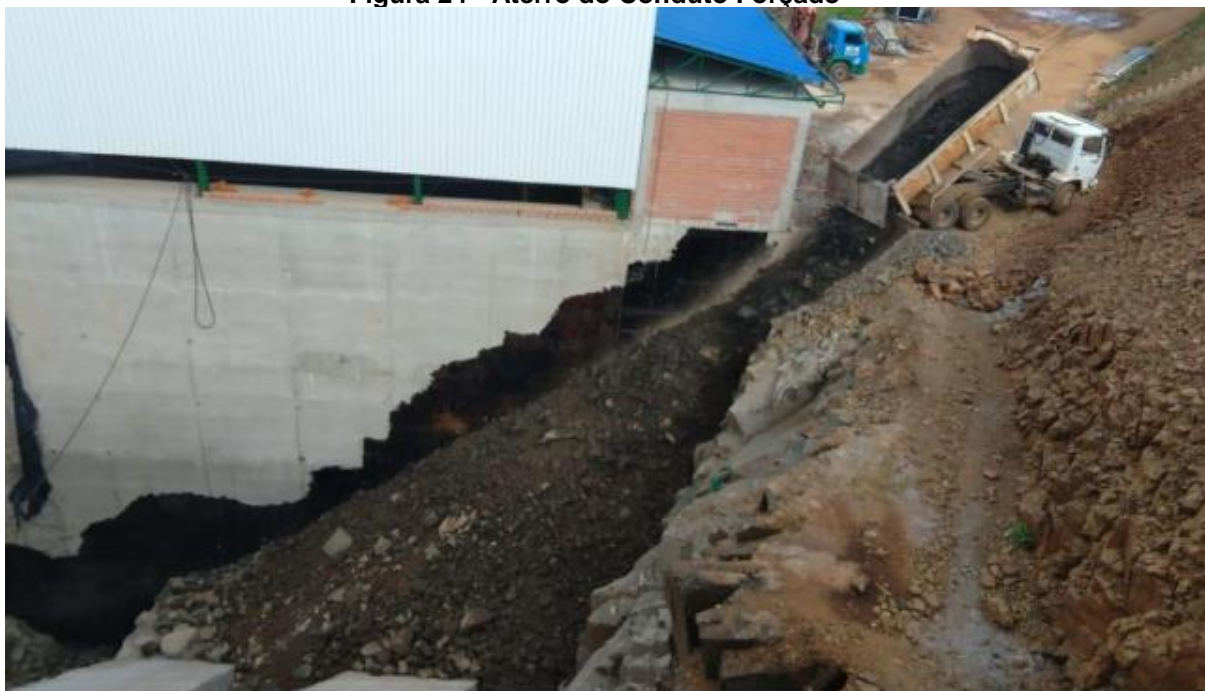
Figura 24 - Aterro do Conduto Forçado
