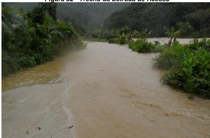
Figura 32 - Trecho da Estrada de Acesso
