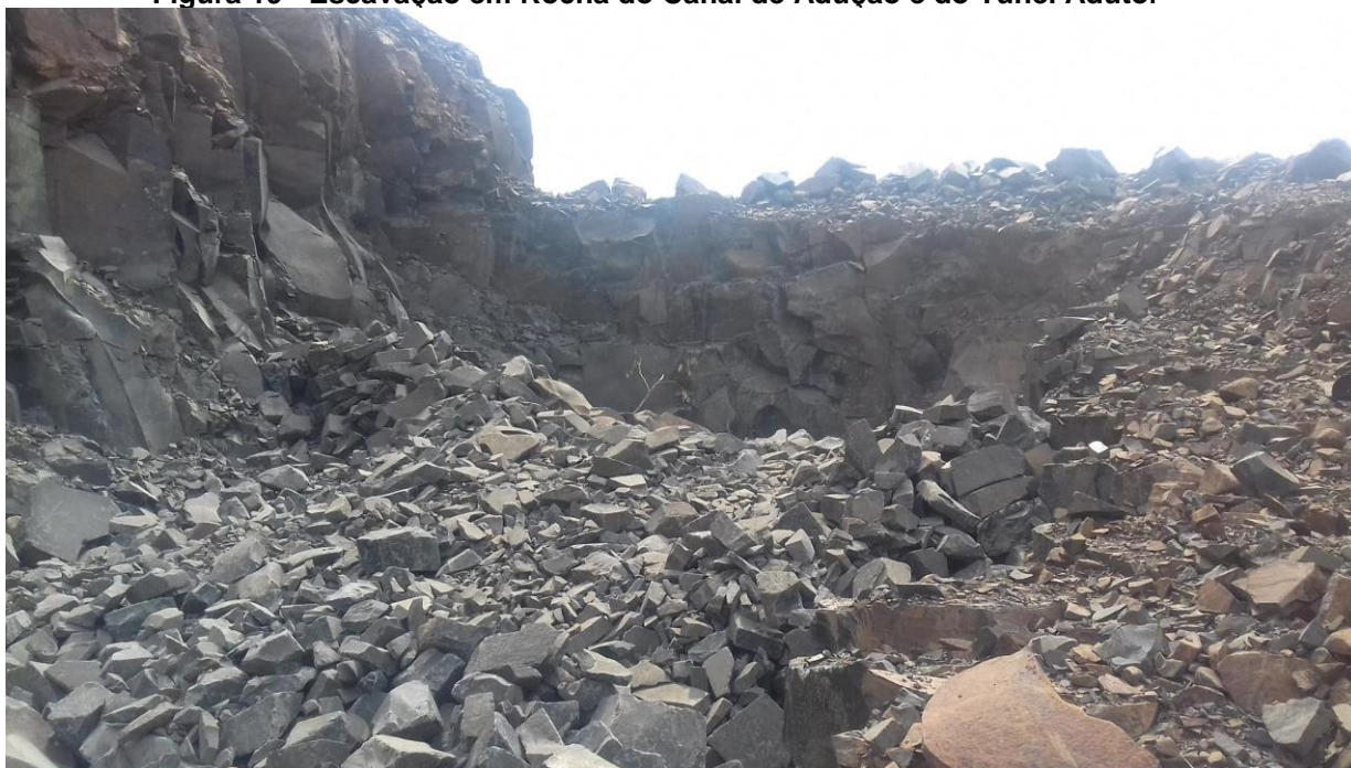
Figura 19 - Escavação em Rocha do Canal de Adução e do Túnel Adutor
