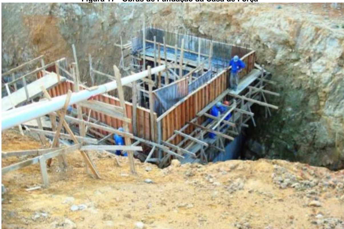
Figura 17 - Obras de Fundação da Casa de Força
