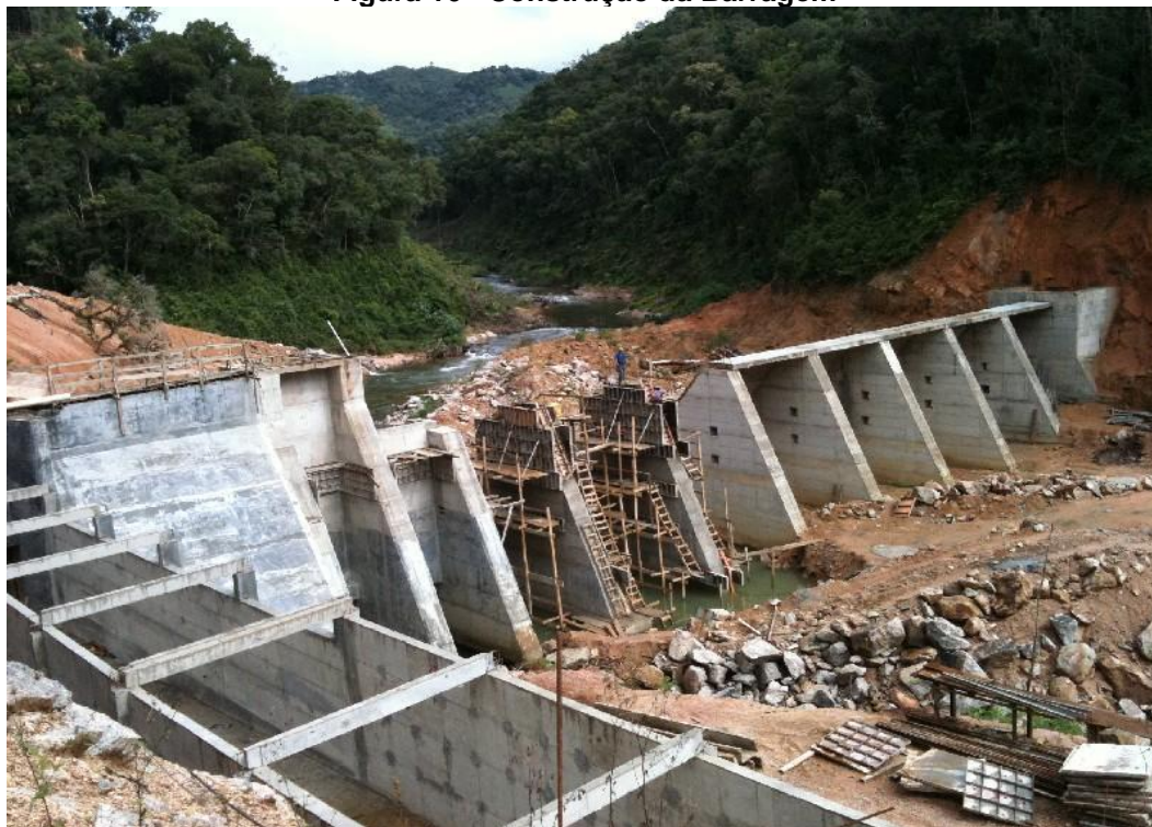
Figura 16 - Construção da Barragem
