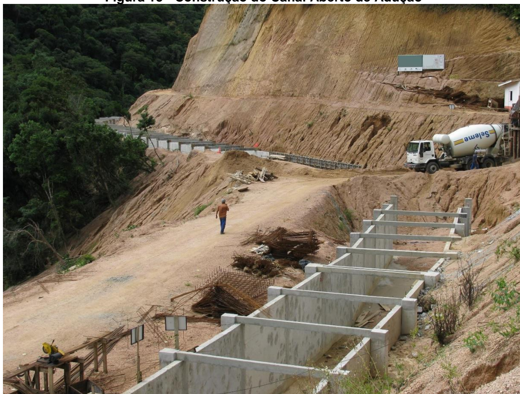
Figura 15 - Construção do Canal Aberto de Adução
