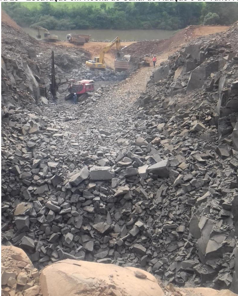
Figura 20 - Escavação em Rocha do Canal de Adução e do Túnel Adutor
