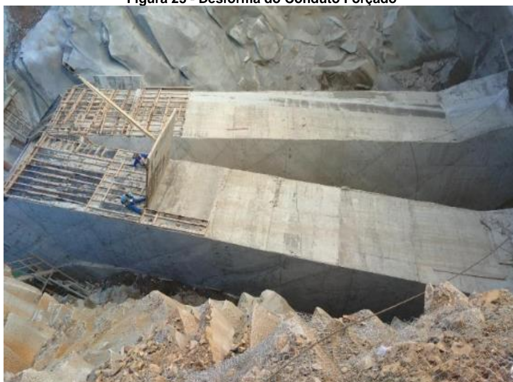
Figura 23 - Desforma do Conduto Forçado
