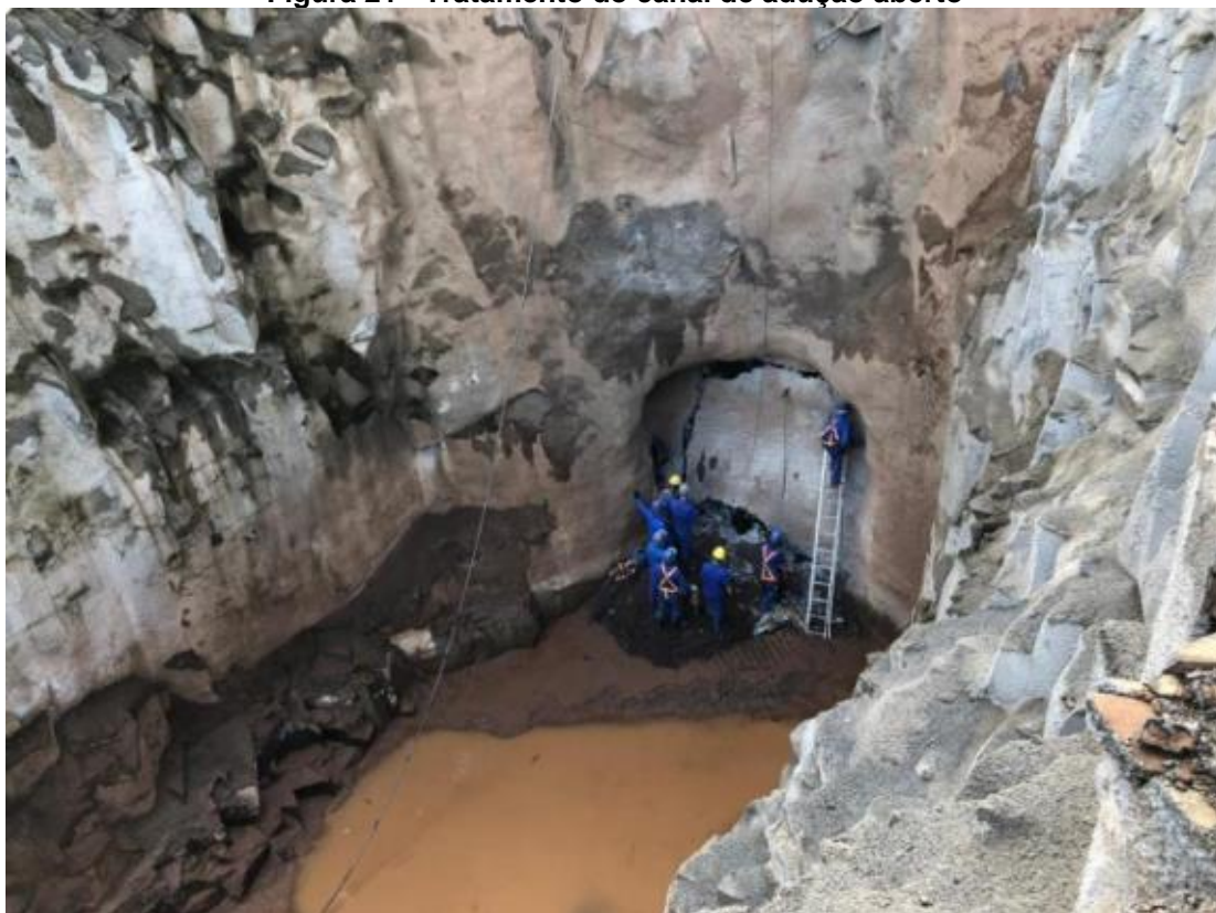
Figura 21 - Tratamento do canal de adução aberto
