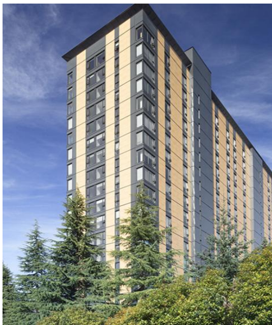
Figura 16: Edifício Brock Commons Tallwood House, Canadá
