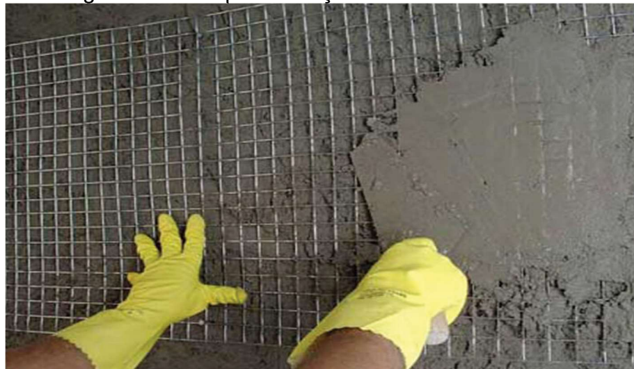
Figura 55 - Tela para reforço em fachada.
