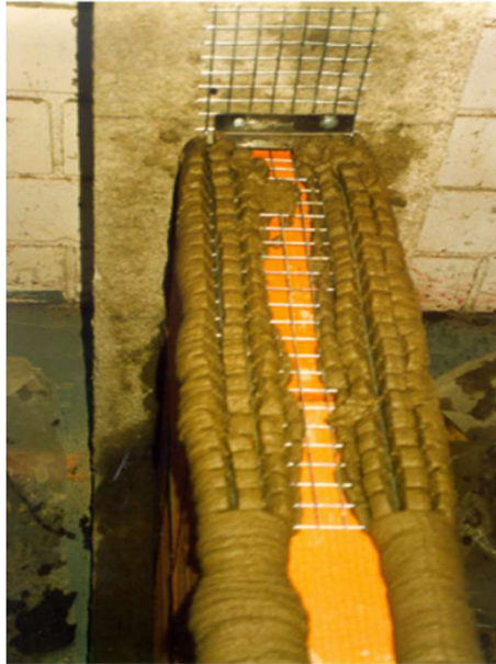
Figura 54 - Tela metálica colocada por meio de fixação à pólvora.
