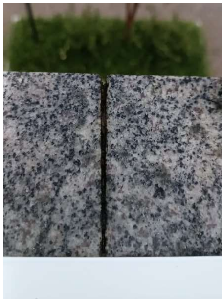
Figura 45 - União entre pedras do peitoril sem vedação.
