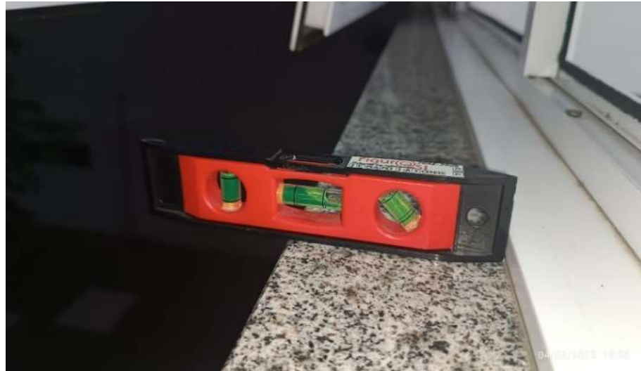
Figura 40 – Pingadeira em peitoril de janela com inclinação correta.
