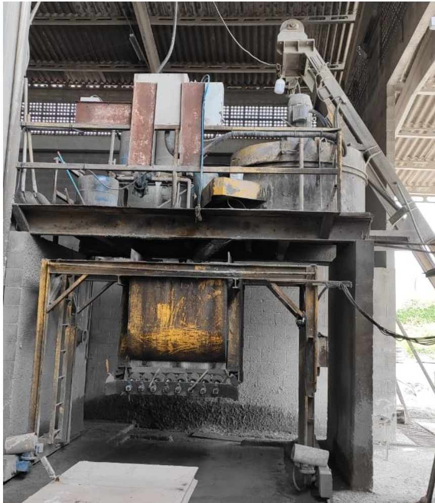
Figura 5 - Misturador e equipamento que distribuí o concreto nas formas
