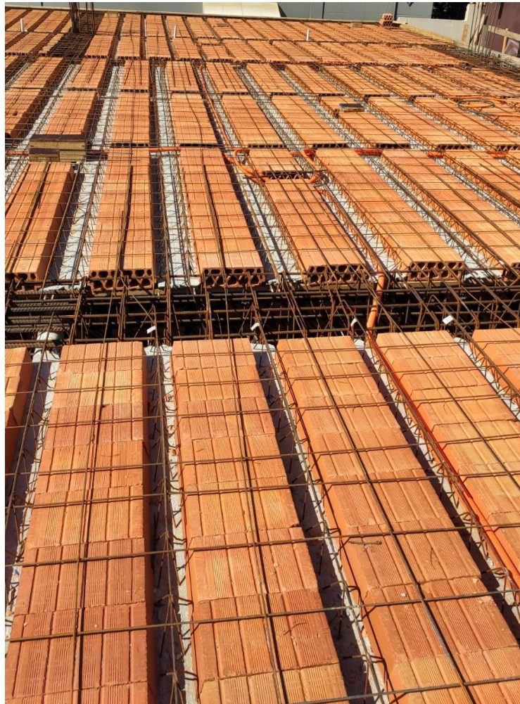
Figura 2 - Laje treliçada unidirecional com enchimento cerâmico
