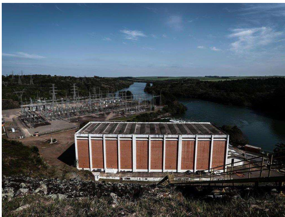
Figura 15 – Usina Hidrelétrica de Passo Real
