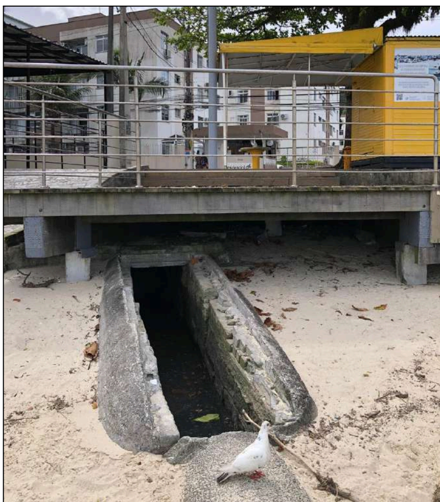
Figura 59 – Vista da saída da galeria pluvial no Ponto 10 – Point do Piva
