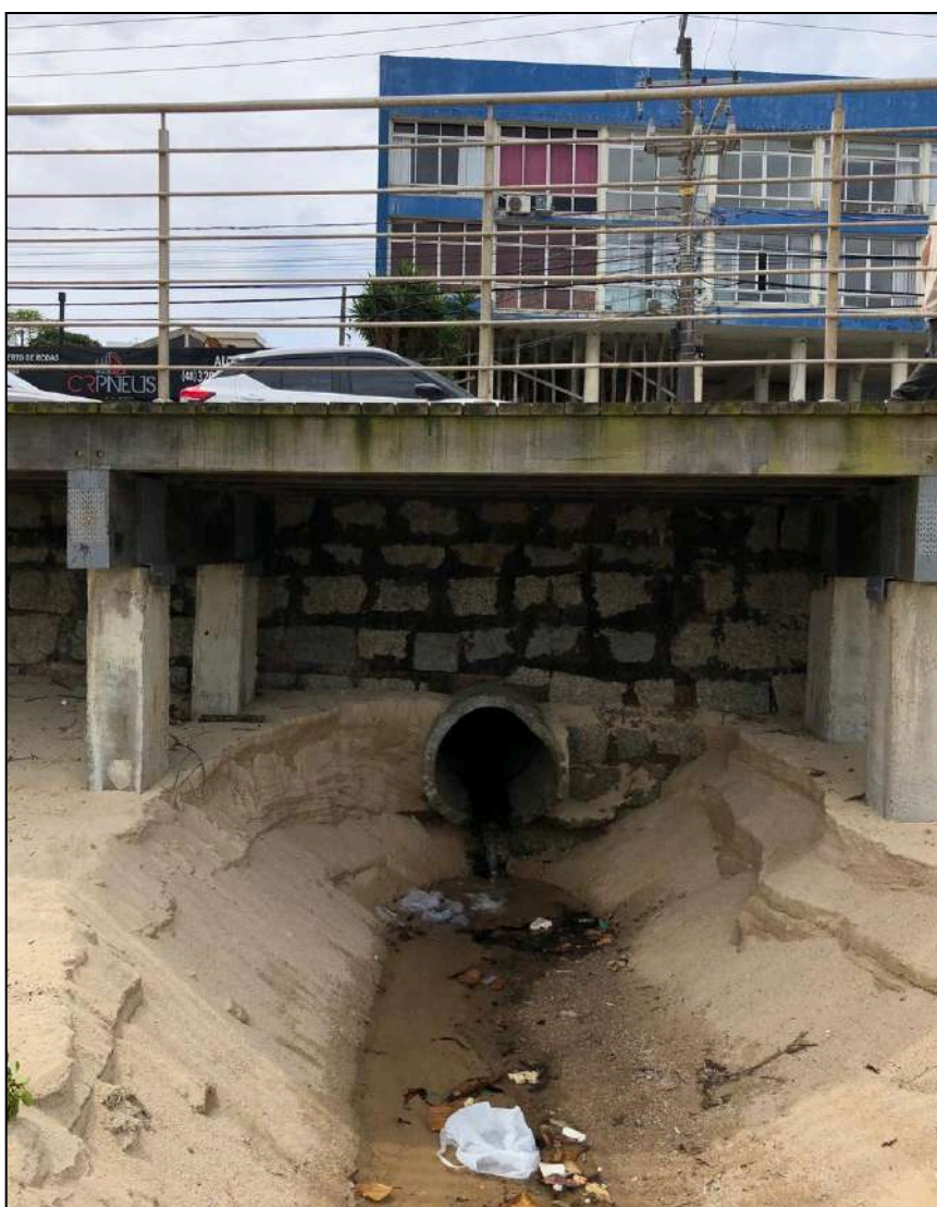
Figura 53 – Vista da saída da galeria pluvial no Ponto 4 – Edifício Normandie
