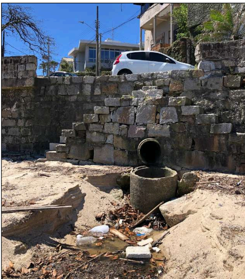
Figura 50 – Vista da saída da galeria pluvial no Ponto 1 – Rua Ver. José do Vale Pereira
