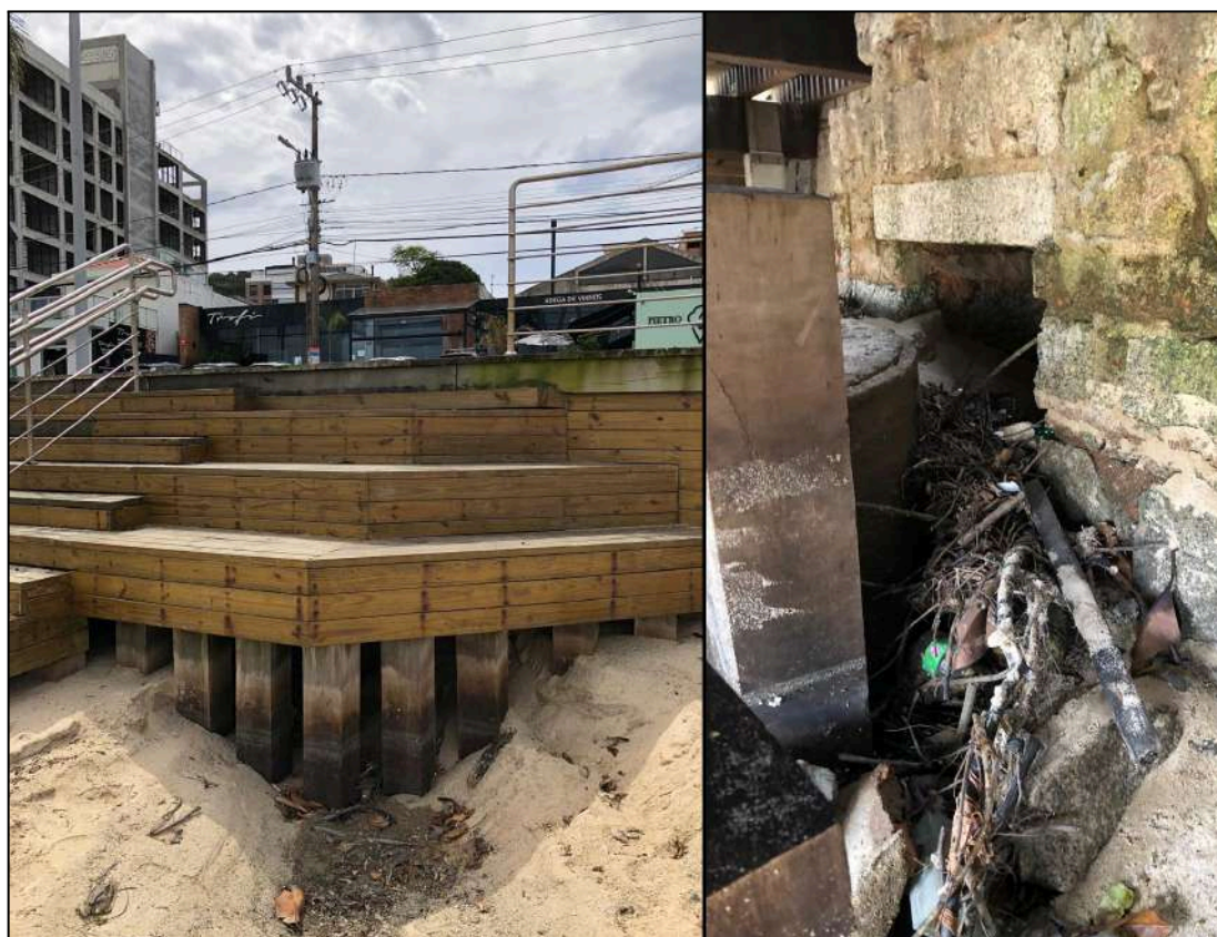
Figura 54 – Vista da saída da galeria pluvial no Ponto 5 – Deck Restaurante Trofi. À esquerda, vista externa do deck; à direita, vista interna, abaixo do deck.
