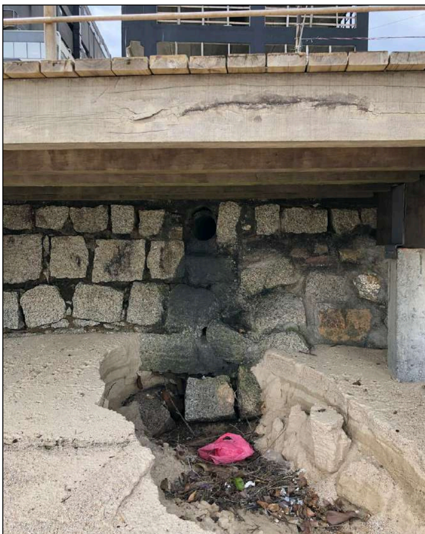
Figura 55 – Vista da saída da galeria pluvial no Ponto 6 - Edifício em Construção
