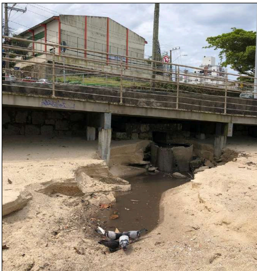
Figura 52 – Vista da saída da galeria pluvial no Ponto 3 – Rua Pascoal Simone
