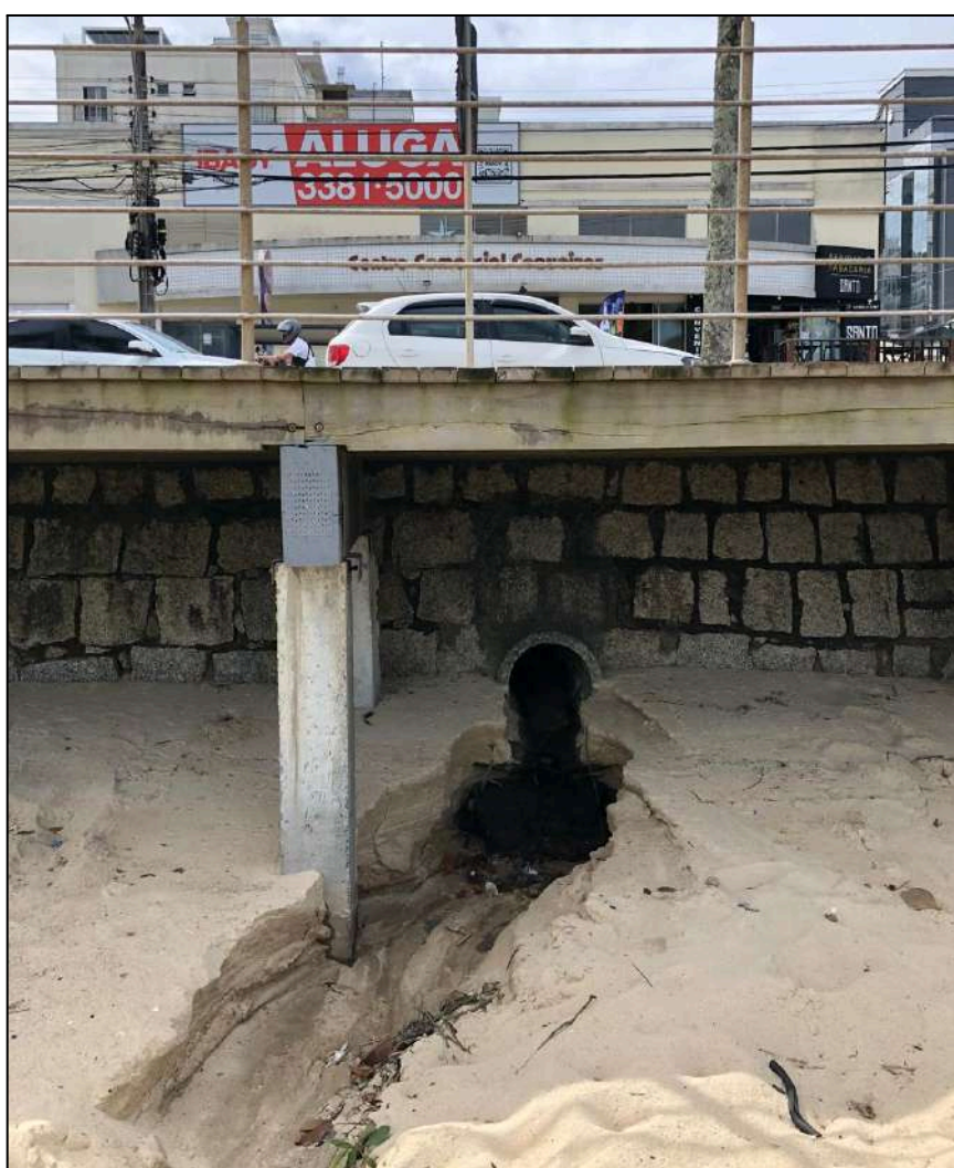
Figura 57 – Vista da saída da galeria pluvial no Ponto 8 – Centro Comercial Coqueiros
