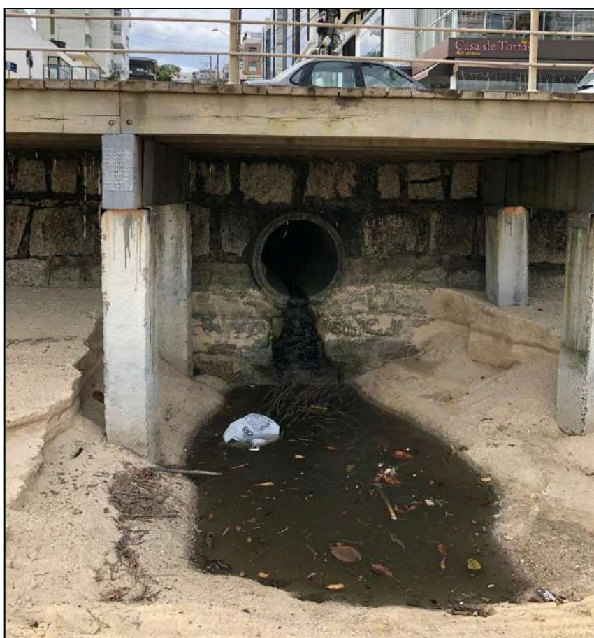
Figura 56 – Vista da saída da galeria pluvial no Ponto 7 – Rua Fritz Muller
