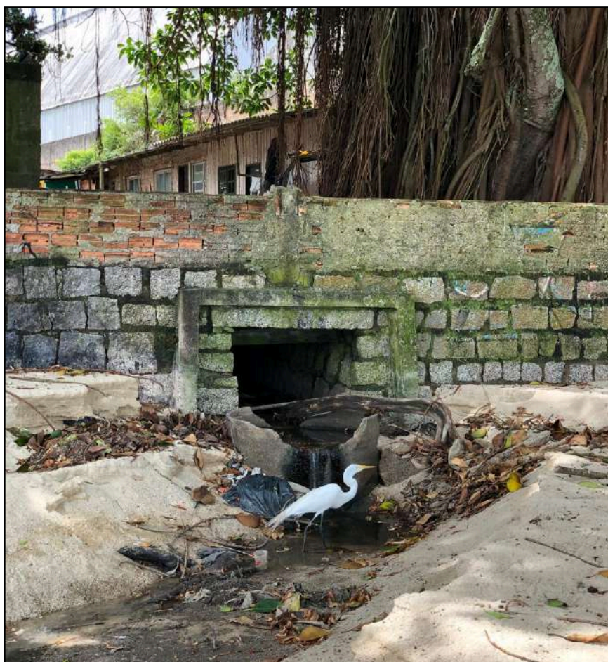
Figura 51 – Vista da saída da galeria pluvial no Ponto 2 – Ranchos dos Pescadores
