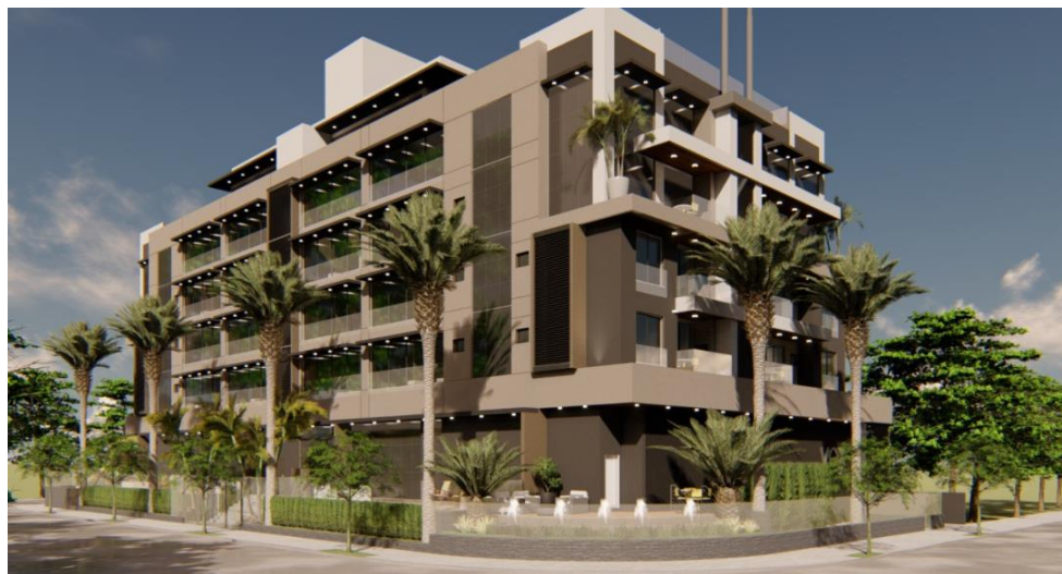
Figura 4 – Fachada do edifício
