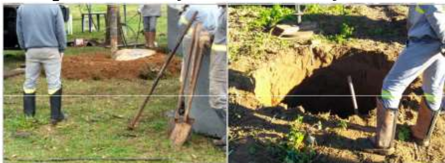
Figura 12 - Escavação à trado e Escavação manual
