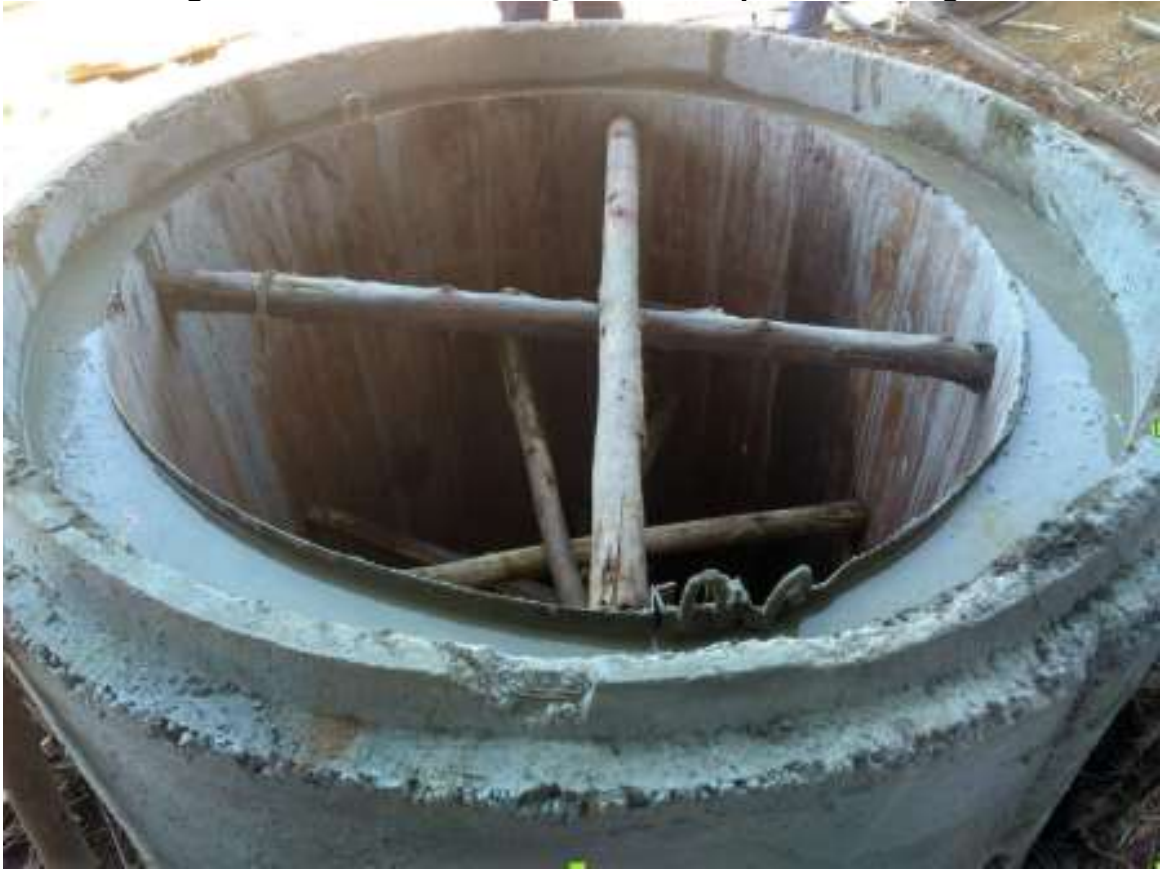
Figura 14 - Foto de Fundação Manilha pós-concretagem
