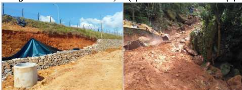
Figura 11 - Corte e Contenção (a) e Abertura de Acesso (b)
