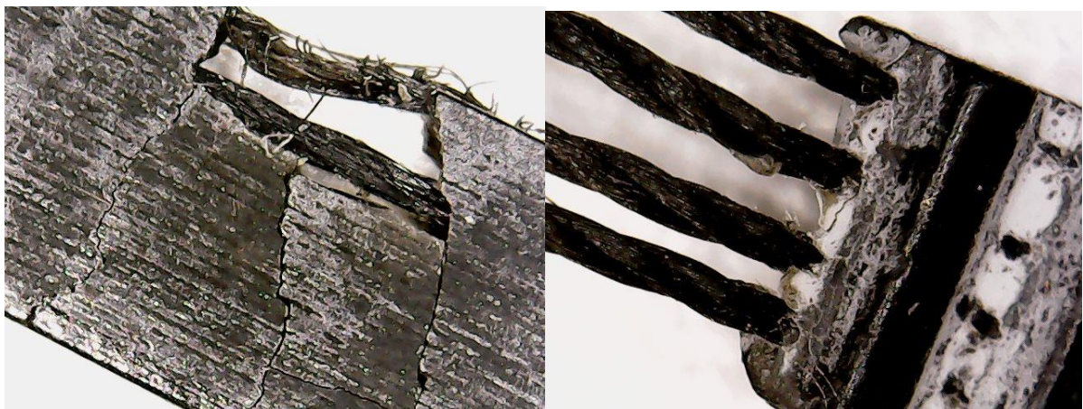
Figura 26 - Detalhe da falha encontrada em campo
