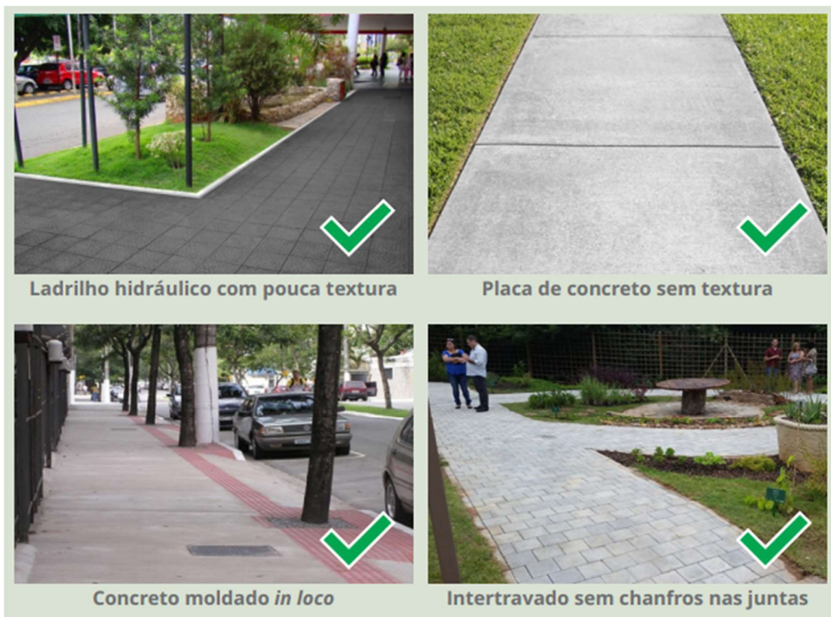
Figura 4 - Pavimentação de Calçada
