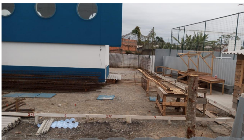
Figura 5 – Registro geral da obra em execução
