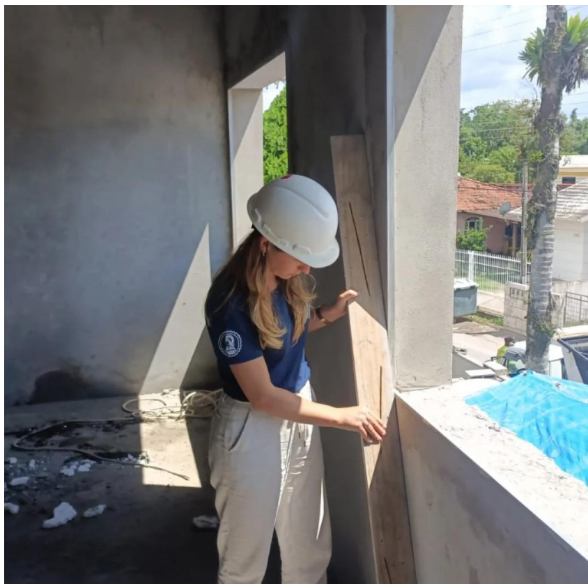
Figura 6 – Atuação da autora na execução da edificação
