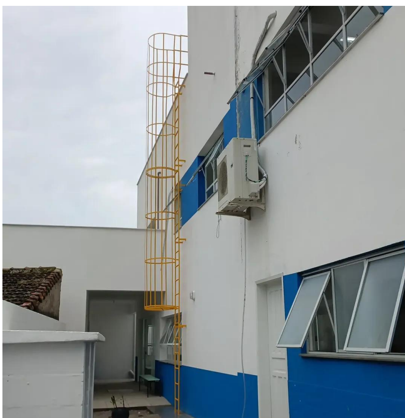
Figura 14 – Execução da escada tipo marinheiro
