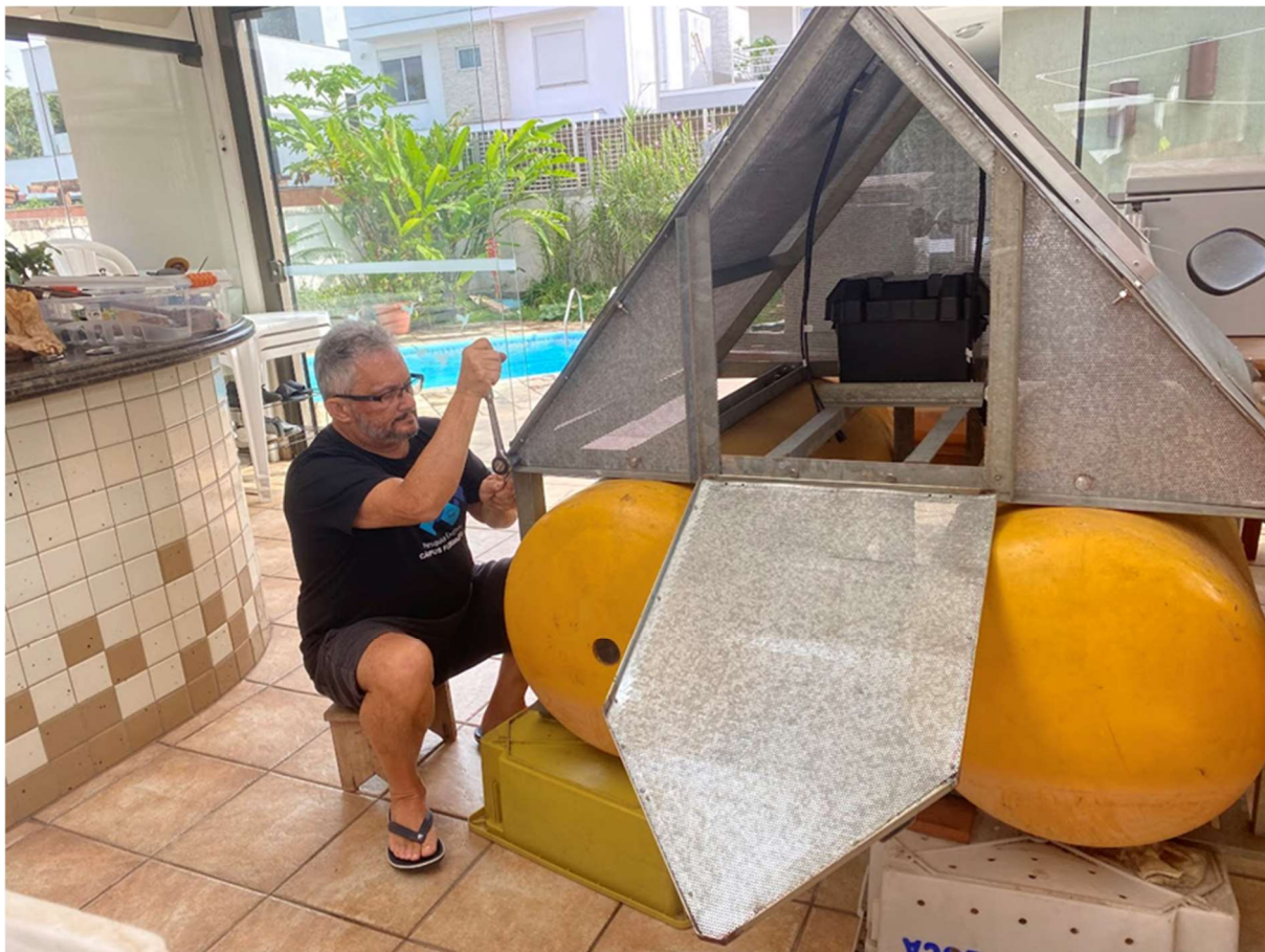
Figura 18 - Finalização da montagem e fechamento da estrutura da Estação Marítima
