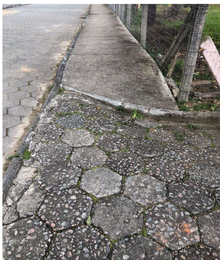
Figura 28 – Esquinas sem rebaixo e orientação
