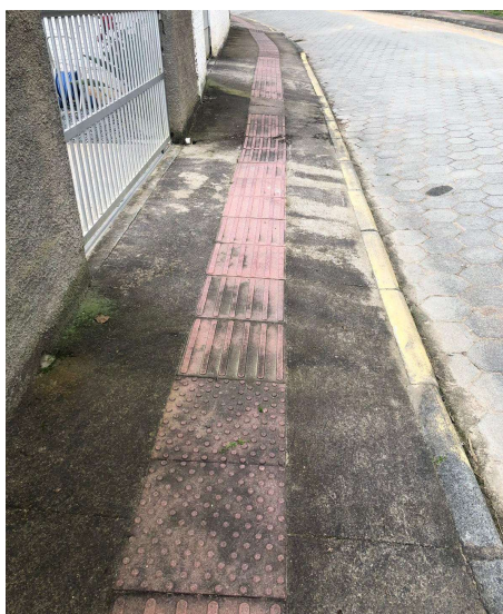
Figura 27 – Entrada de veículos com rebaixo e piso tátil direcional errôneo na calçada
