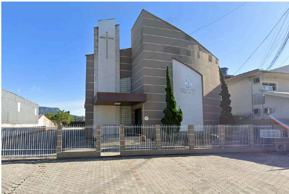
Figura 3 – Fachada Igreja Adventista Central de Palhoça
