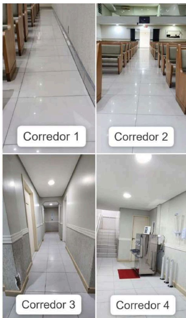
Figura 45 – Corredores do térreo da edificação
