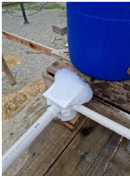
Figura 48 – Retorno de espuma por excesso de pressão
