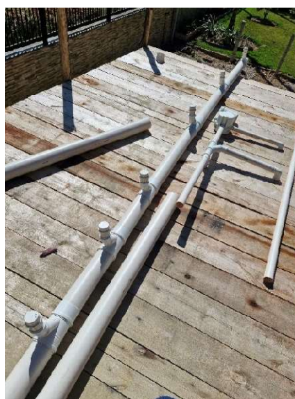
Figura 27 – Construção da transição de prumada
