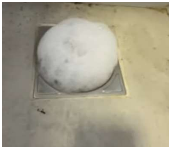
Figura 03 – Retorno de espuma em caixa sifonada
