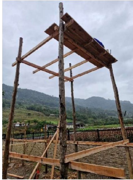
Figura 22 – Assoalho pavimento superior em construção
