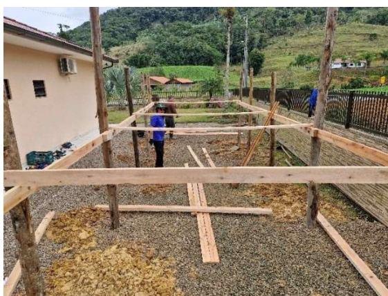
Figura 19 – Vigas laterais pavimento de transição
