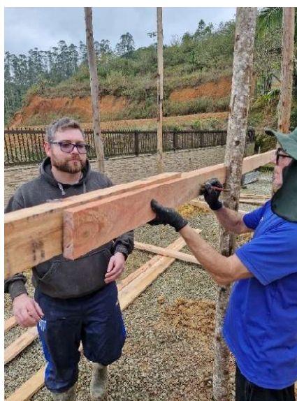
Figura 18 – Medições das vigas
