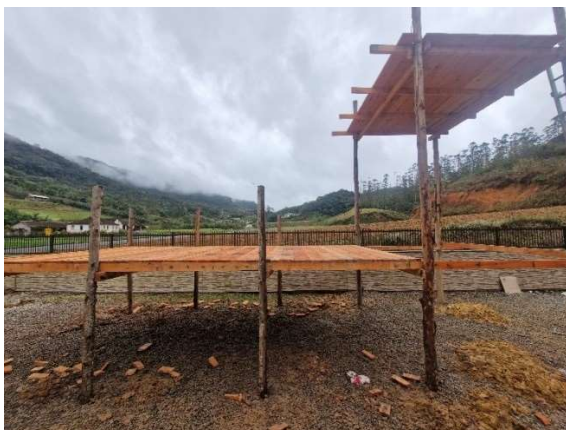
Figura 24 – Assoalho da estrutura completo
