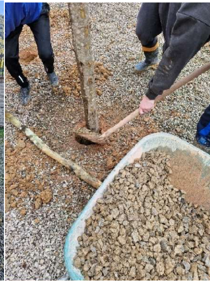
Figura 16 – Assentamento de escoras
