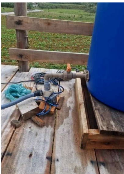
Figura 29 – Conexão da bomba ao barril
