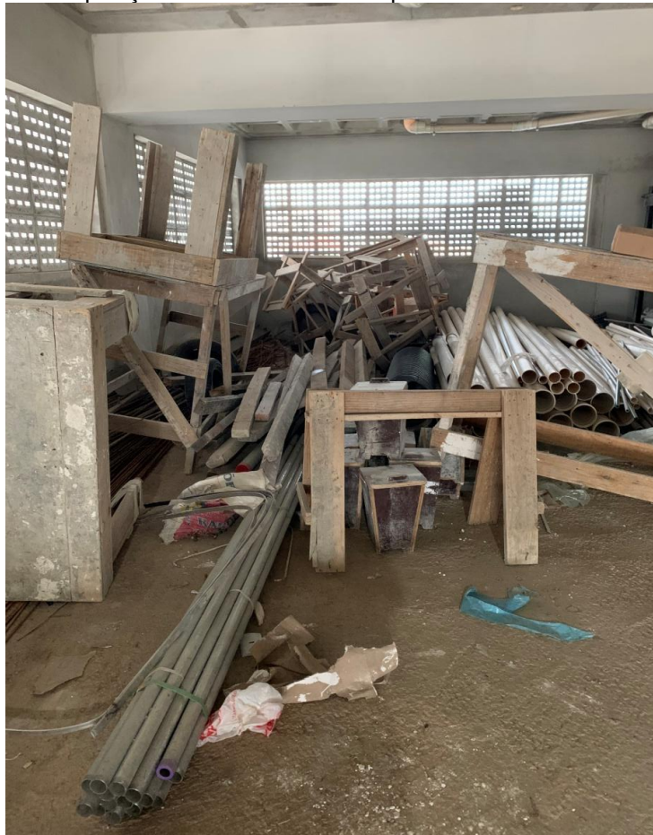
Figura 16 - Disposição dos resíduos e estoque dos tubos de PVC e madeira
