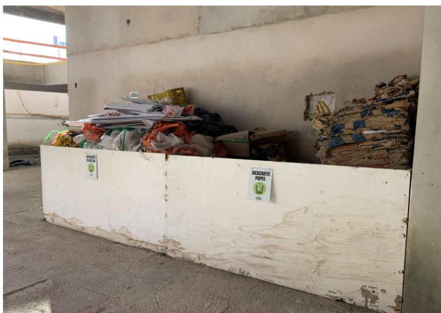
Figura 12 - Baias para descarte dos RCC da empresa B
