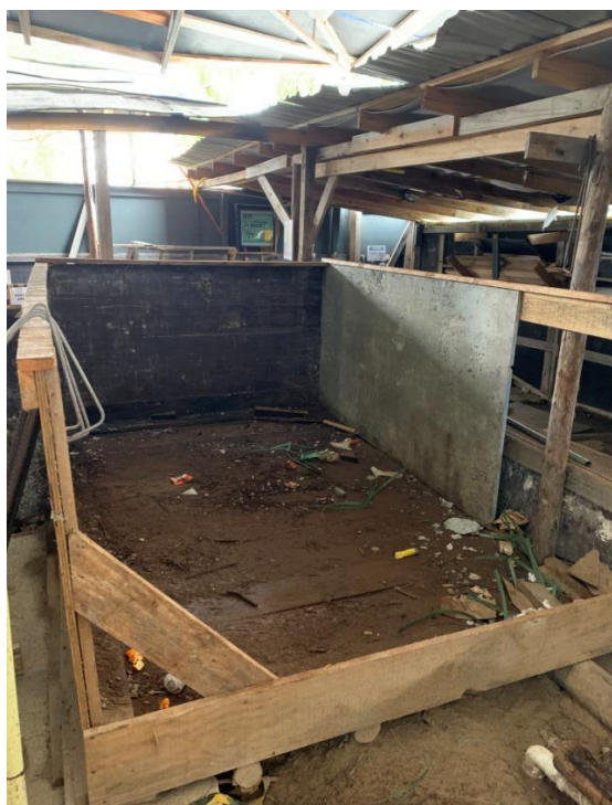
Figura 25 - Baia para acondicionamento do aço na empresa F
