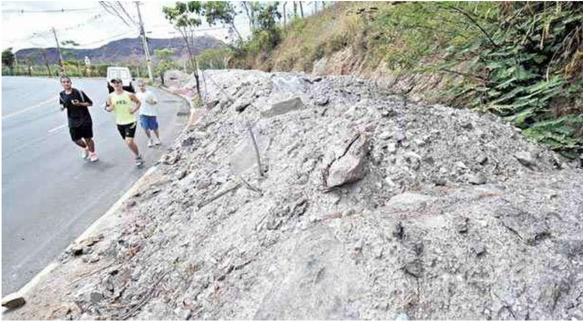
Figura 3 - Deposição de resíduos em calçada
