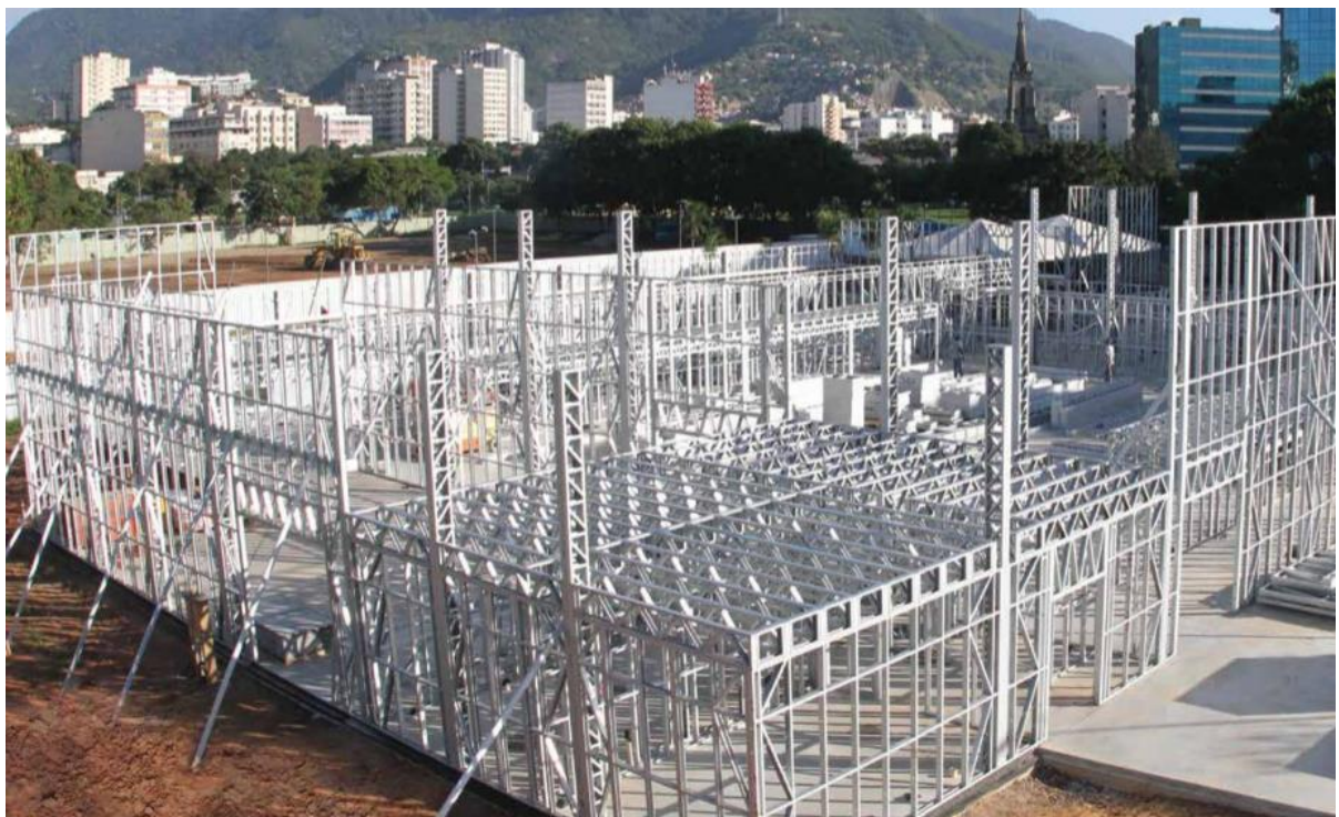
Figura 1- Sistema construtivo em Light Steel Framing
