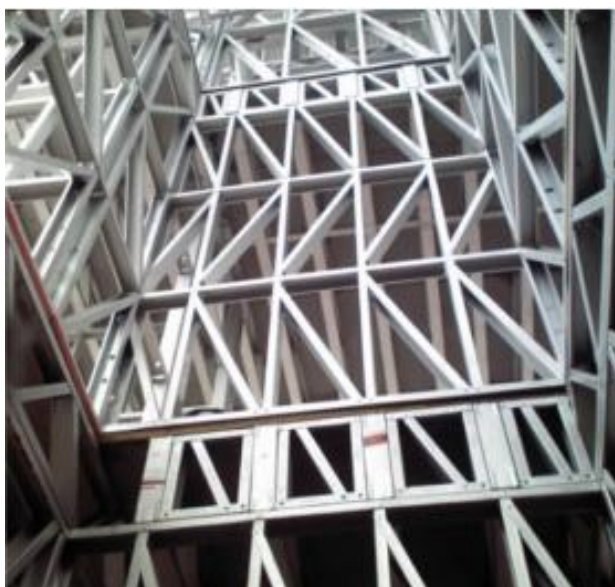
Figura 15 - Contraventamento em K
