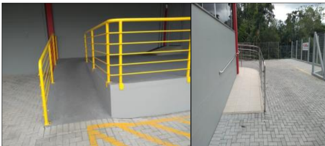
Figura 22 – Rampas de acesso à edificação
