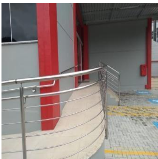
Figura 24 – Pisos de acesso à edificação
