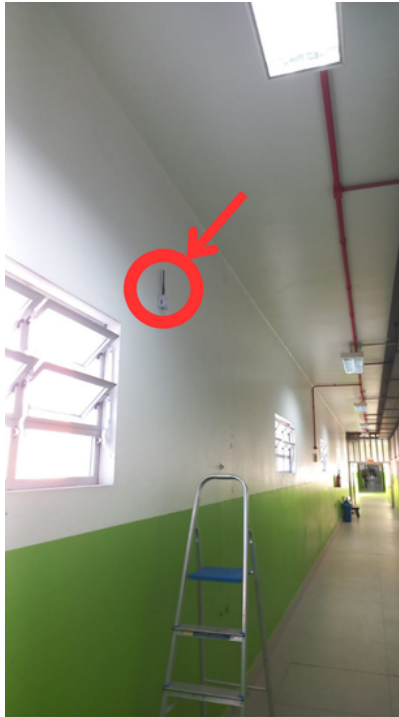
Figura 38 – Local de instalação do dispositivo B
