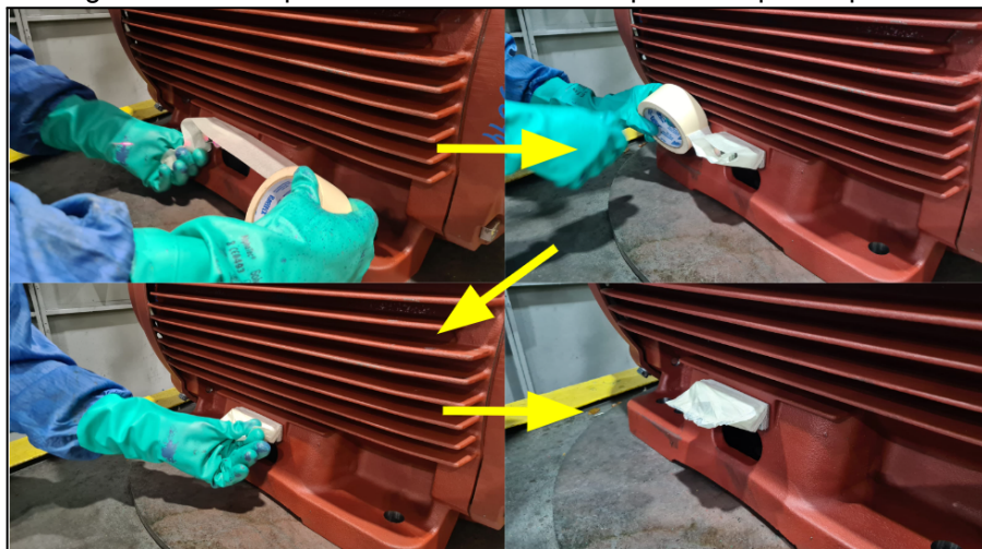
Figura 10 - Exemplo de isolamento dos componentes para a pintura
