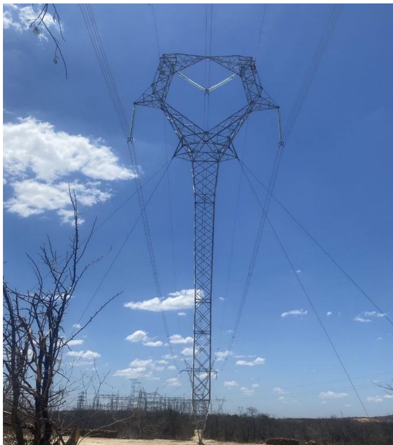
Figura 5 – Estrutura tipo Estaiada
