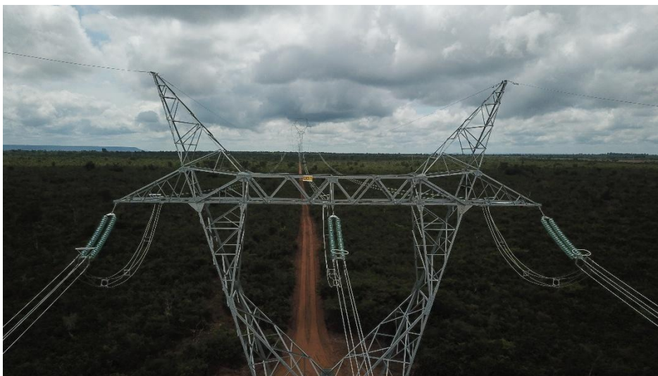
Figura 7 – Estrutura de Ancoragem
