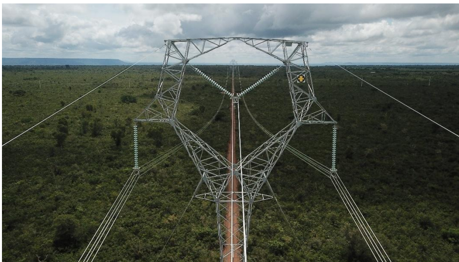
Figura 6 – Estrutura de Suspensão
