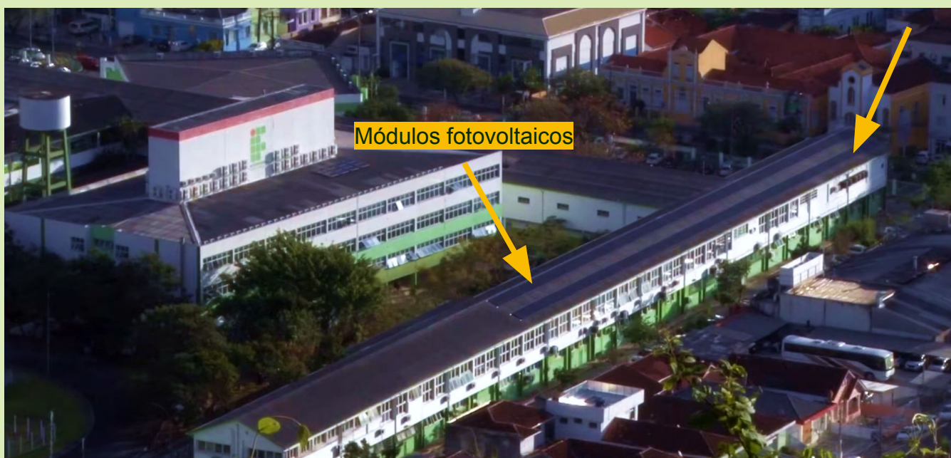
Figura 6 – Imagem aérea da cobertura do IFSC.
