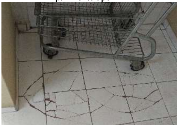
Figura 63 - Piso do corredor do 1º pavimento tipo
