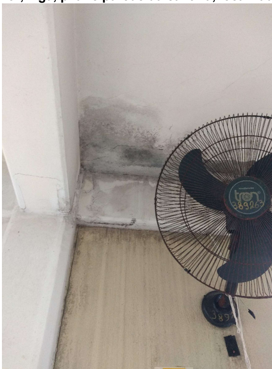
Figura 56 - Laje superior, viga, pilar e parede da cantina, localizada no pavimento térreo
