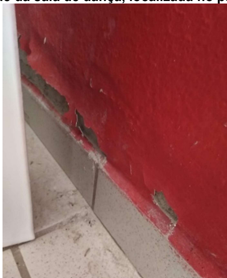
Figura 12 - Parede da sala de dança, localizada no pavimento subsolo
