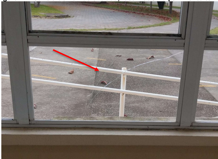
Figura 42 - Janela do hall de entrada, localizado no pavimento térreo
