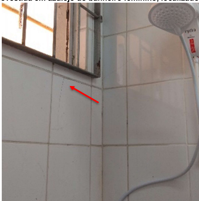
Figura 75 - Parede revestida em azulejo do banheiro feminino, localizado no pavimento térreo
