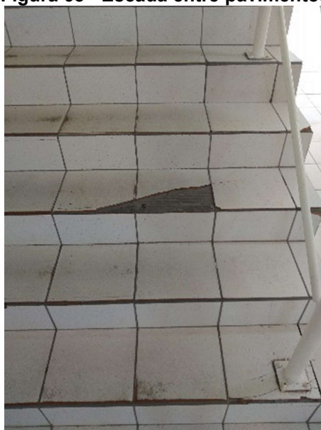
Figura 68 - Escada entre pavimentos
