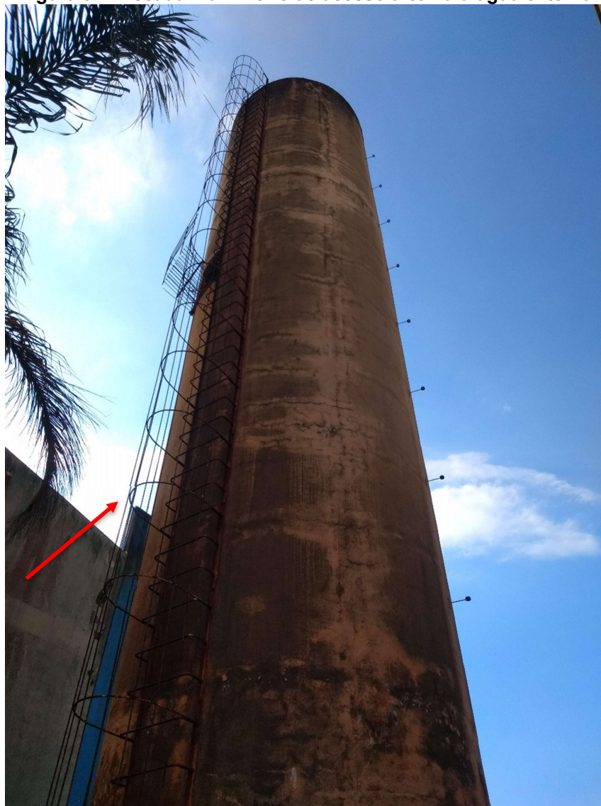
Figura 34 - Escada marinheiro de acesso a caixa d'água externa
