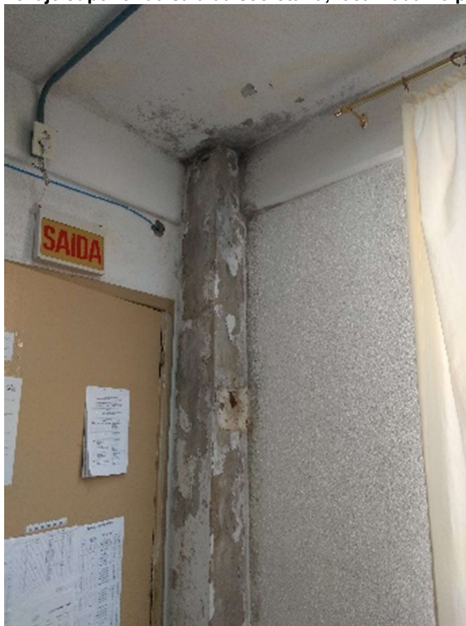
Figura 31 - Pilar e laje superior da sala da secretaria, localizada no pavimento térreo
