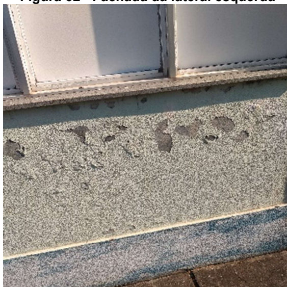
Figura 62 - Fachada da lateral esquerda
