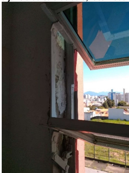
Figura 11 - Lateral da janela da sala de aula, localizada no 2º pavimento tipo
