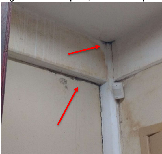
Figura 57 - Viga da sala de arquivo, localizada no pavimento térreo
