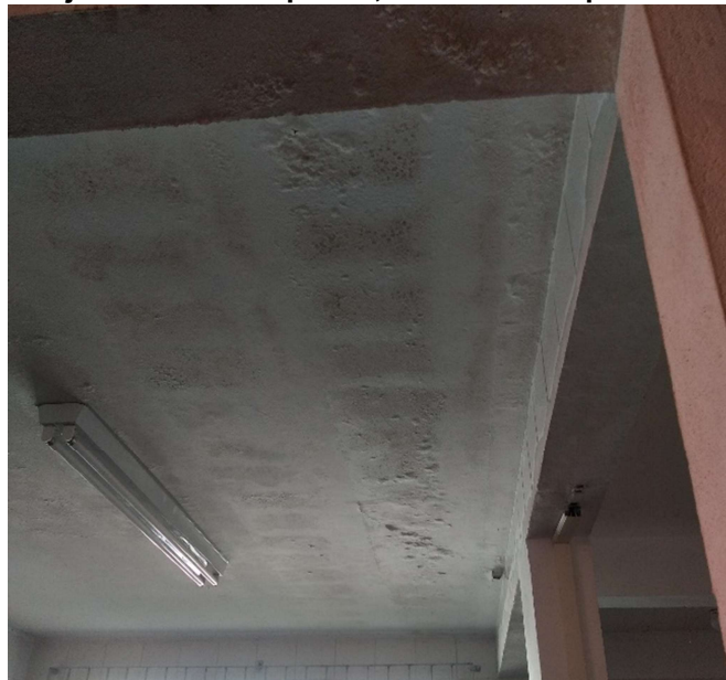
Figura 4 - Laje da sala do depósito, localizado no pavimento subsolo
