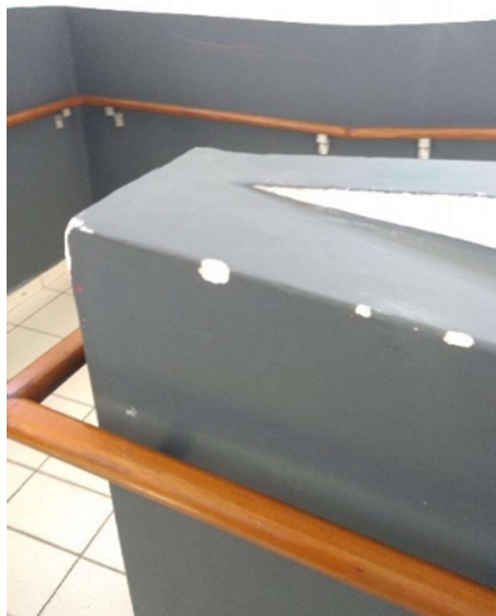
Figura 25 - Divisória da rampa entre pavimentos
