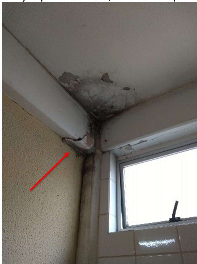
Figura 36 - Laje superior do corredor, localizado no 1º pavimento tipo
