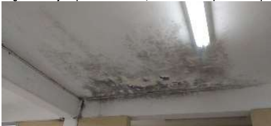
Figura 53 - Laje superior do corredor, localizado no 1º pavimento tipo
