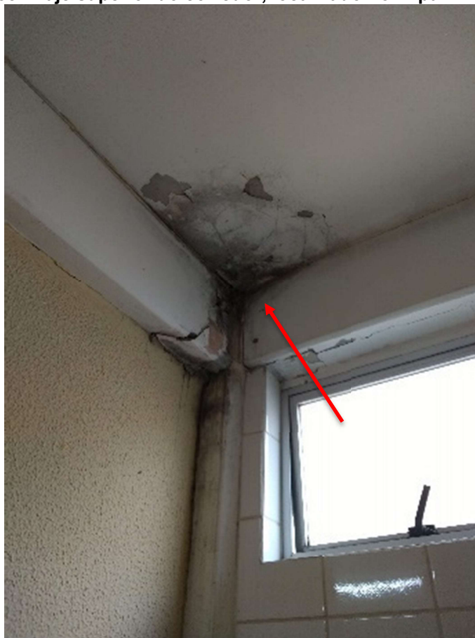
Figura 55 - Laje superior do corredor, localizado no 1º pavimento tipo
