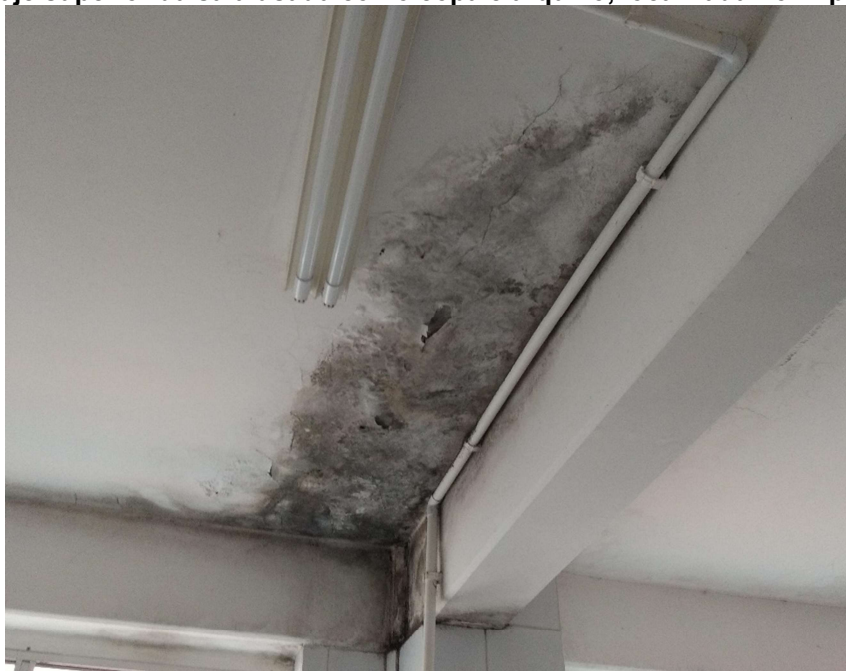
Figura 39 - Laje superior da sala usada como copa e arquivo, localizada no 1º pavimento tipo
