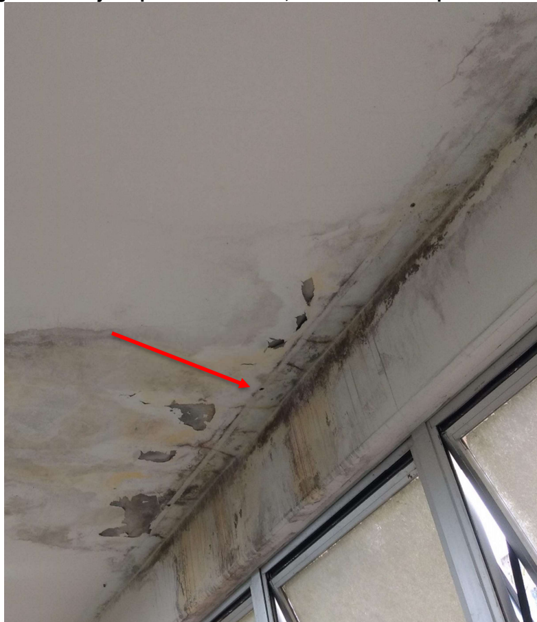
Figura 30 - Laje superior da sala 07, localizada no 1º pavimento tipo
