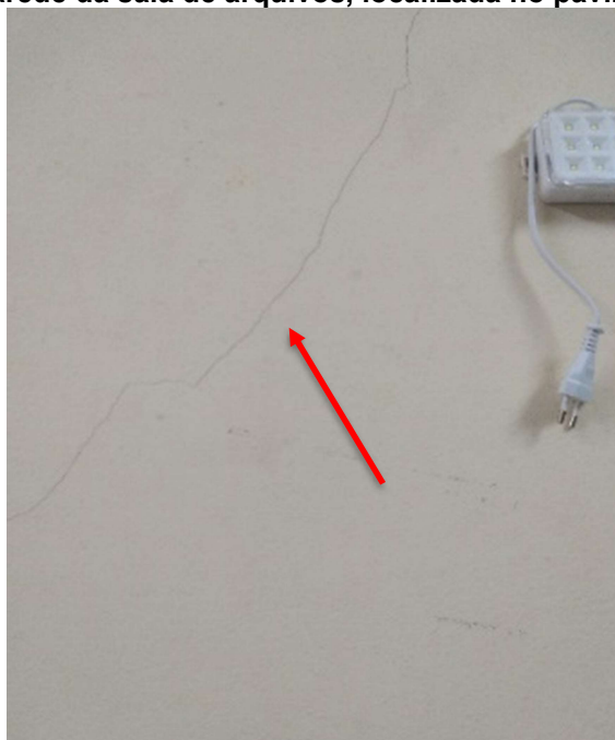
Figura 18 - Parede da sala de arquivos, localizada no pavimento subsolo
