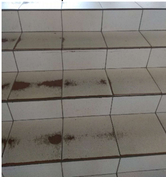
Figura 77 - Degraus da escada entre pavimentos
