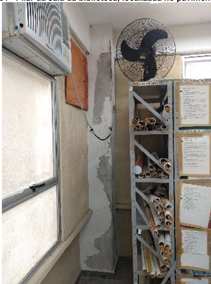
Figura 61 - Pilar da sala da biblioteca, localizada no pavimento térreo
