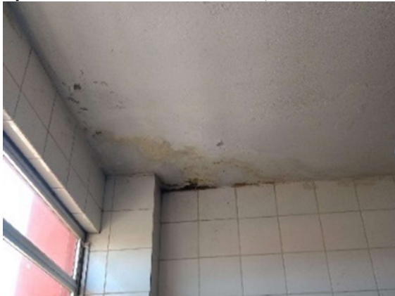
Figura 10 - Laje superior do banheiro feminino, localizado no 2º pavimento tipo
