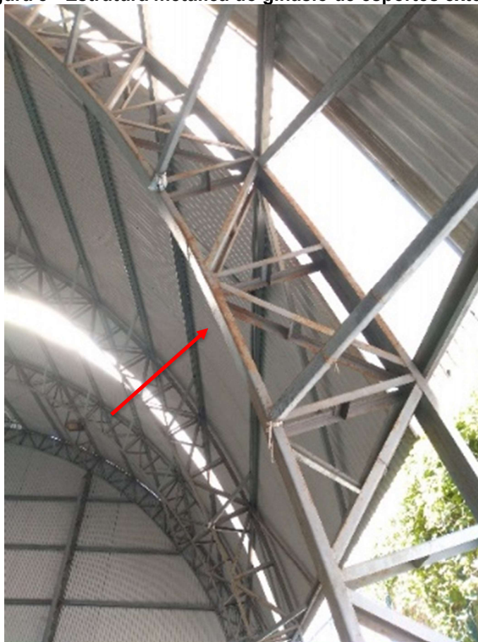
Figura 8 - Estrutura metálica do ginásio de esportes externo
