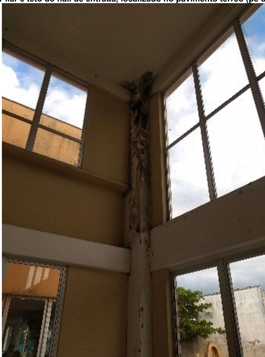
Figura 26 - Pilar e teto do hall de entrada, localizado no pavimento térreo (pé direito duplo)
