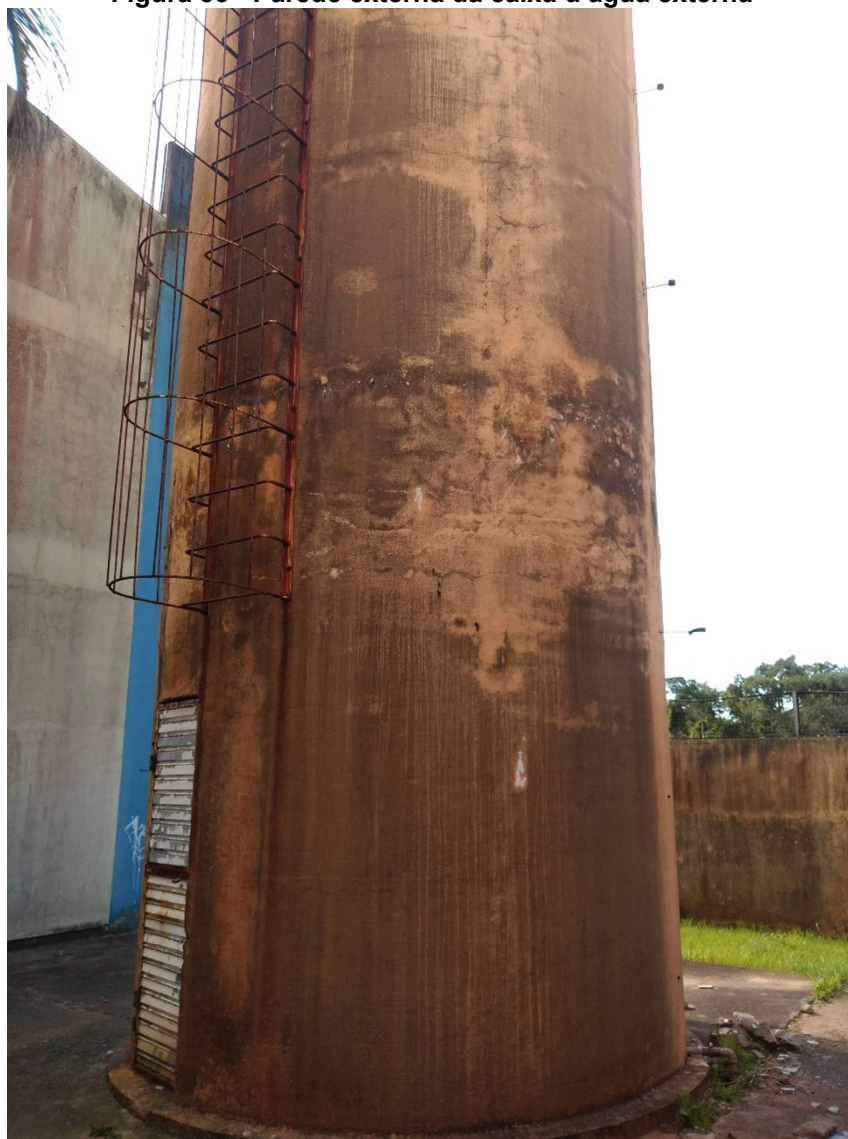
Figura 35 - Parede externa da caixa d'água externa
