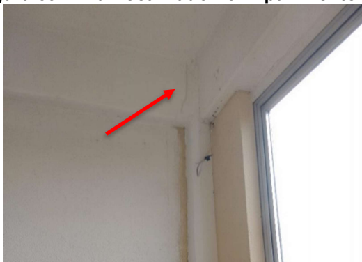
Figura 69 - Pilar localizado no 1º pavimento tipo
