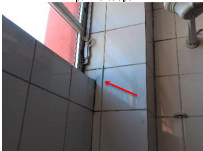
Figura 22 - Parede com revestimento cerâmico do banheiro feminino, localizado no 1º pavimento tipo
