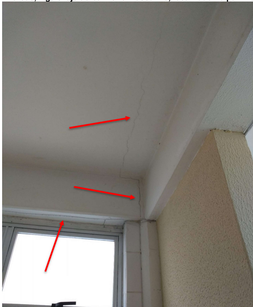
Figura 43 - Parede, viga e laje do banheiro masculino, localizado no pavimento térreo
