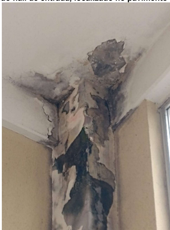
Figura 27 - Pilar e teto do hall de entrada, localizado no pavimento térreo (pé direito duplo)
