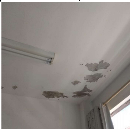
Figura 9 - Laje superior da sala de aula, localizada no 2º pavimento tipo
