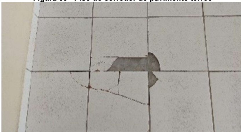
Figura 65 - Piso do corredor do pavimento térreo
