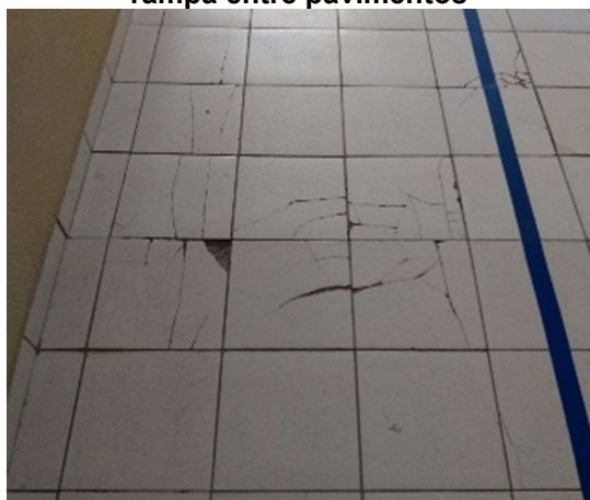
Figura 66 - Revestimento cerâmico da rampa entre pavimentos
