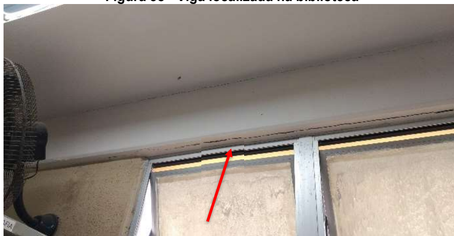
Figura 38 - Viga localizada na biblioteca
