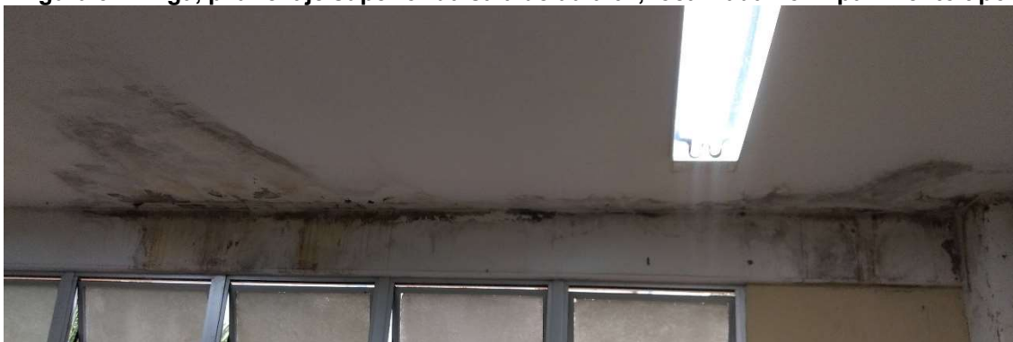
Figura 32 - Viga, pilar e laje superior da sala de aula 07, localizada no 1º pavimento tipo
