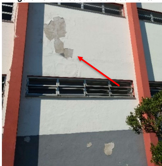
Figura 19 - Parede da fachada frontal
