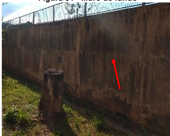
Figura 51 - Muro de fundo
