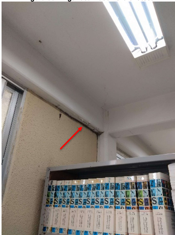
Figura 58 - Viga localizada na biblioteca
