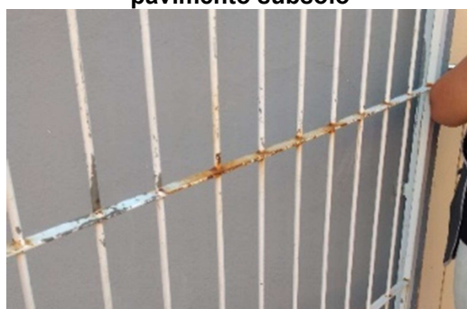
Figura 20 - Grade externa da porta de entrada da sala de educação física, localizada no pavimento subsolo
