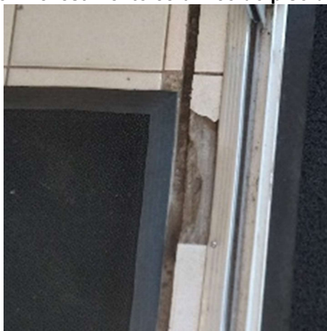
Figura 23 - Revestimento cerâmico do piso de entrada
