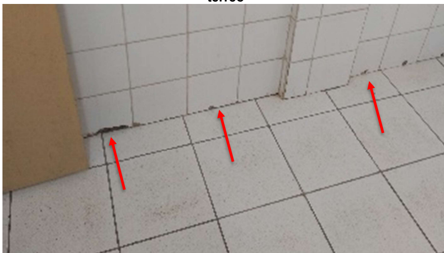
Figura 76 - Parede revestida com cerâmica no banheiro masculino, localizado no pavimento térreo
