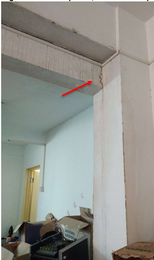
Figura 3 - Pilar e viga da sala do depósito, localizado no pavimento subsolo
