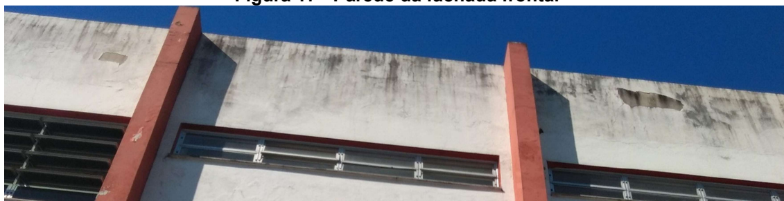
Figura 17 - Parede da fachada frontal
