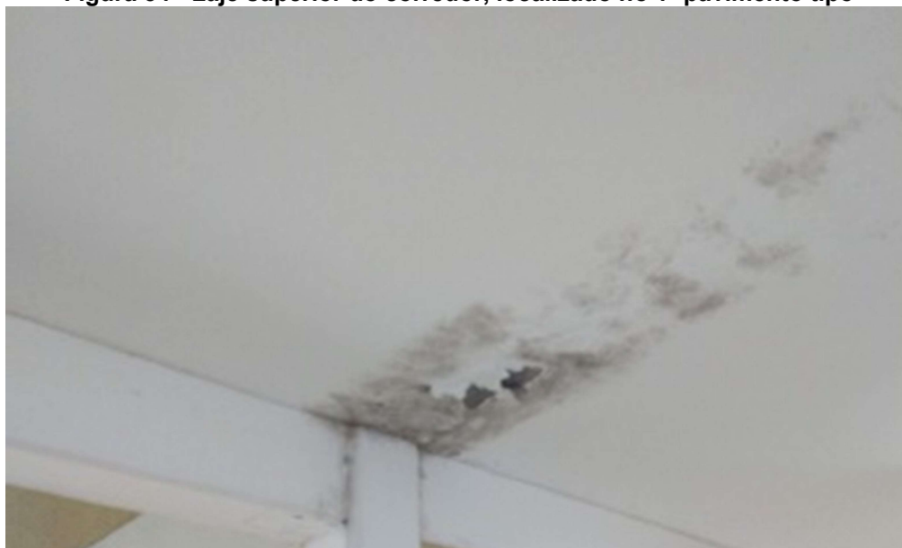
Figura 54 - Laje superior do corredor, localizado no 1º pavimento tipo
