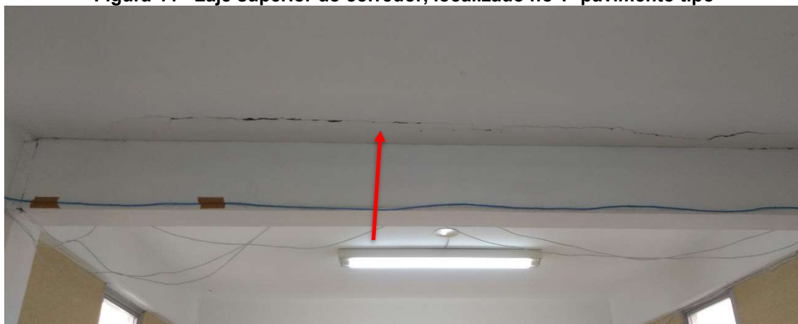
Figura 44 - Laje superior do corredor, localizado no 1º pavimento tipo
