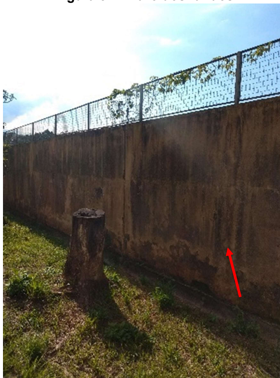
Figura 52 - Muro dos fundos
