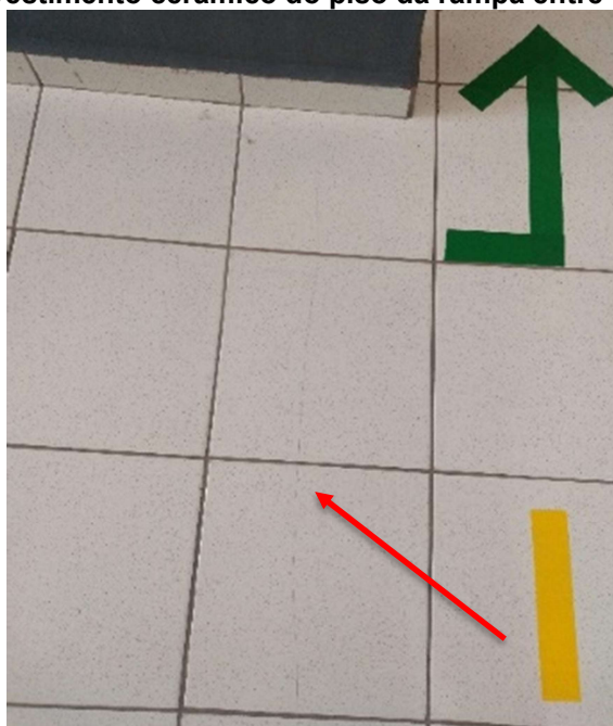
Figura 7 - Revestimento cerâmico do piso da rampa entre os pavimentos
