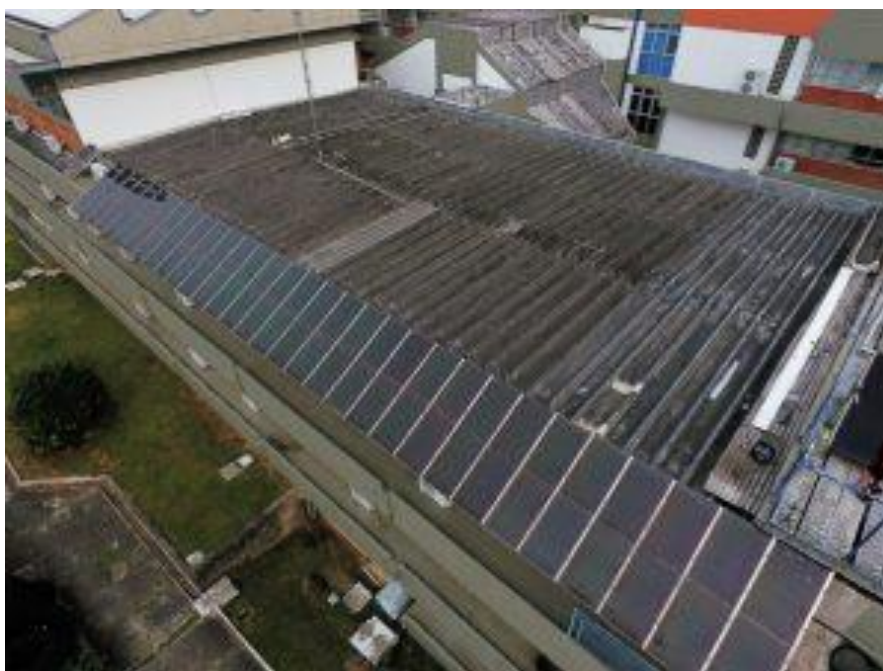
Figura 7 – Sistema Fotovoltaico no campus da UFSC
