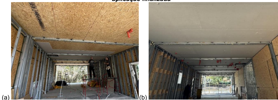
Figura 120 – Aplicação da chapa ST na primeira etapa do forro: (a) início da aplicação; (b) aplicação finalizada
