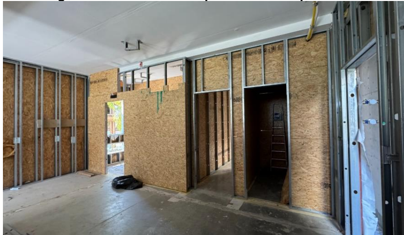
Figura 129 – Primeiro chapeamento com placa OSB
