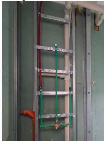
Figura 134 – Instalação hidráulica no shaft do banheiro
