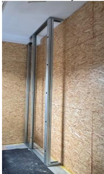
Figura 137 – Estruturação dos shafts
