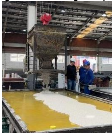
Figura 52 – Concretagem do piso
