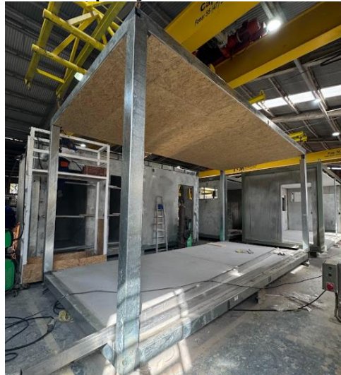
Figura 68 – Composição estrutural final do módulo
