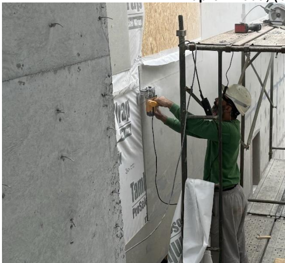
Figura 112 – Aplicação da placa cimentícia nas paredes externas do módulo: (a) vista aproximada; (b) vista geral
