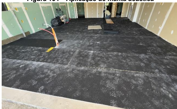
Figura 154 – Aplicação de manta acústica
