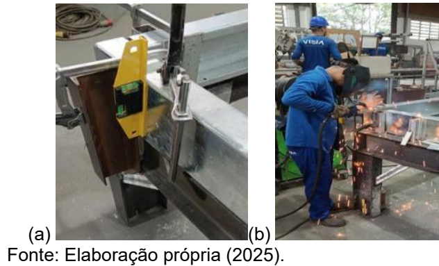
Figura 56 – Montagem do quadro estrutural: (a) encaixe e travamento dos perfis; (b) soldagem dos encaixes
