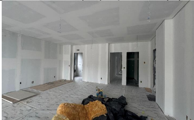
Figura 150 – Primeira etapa: aplicação do fundo preparador
