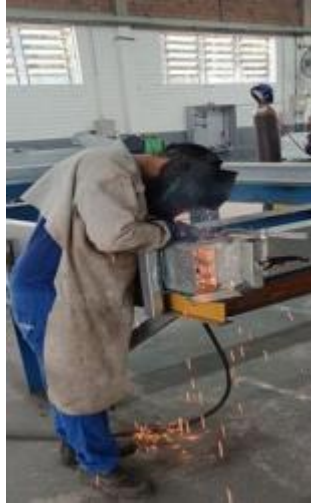
Figura 58 – Soldagem definitiva dos perfis estruturais
