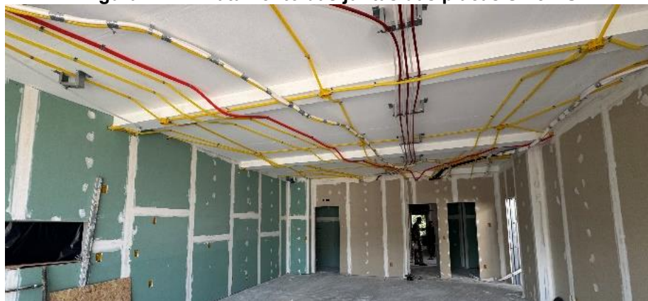
Figura 142 – Tratamento das juntas das placas ST e RU
