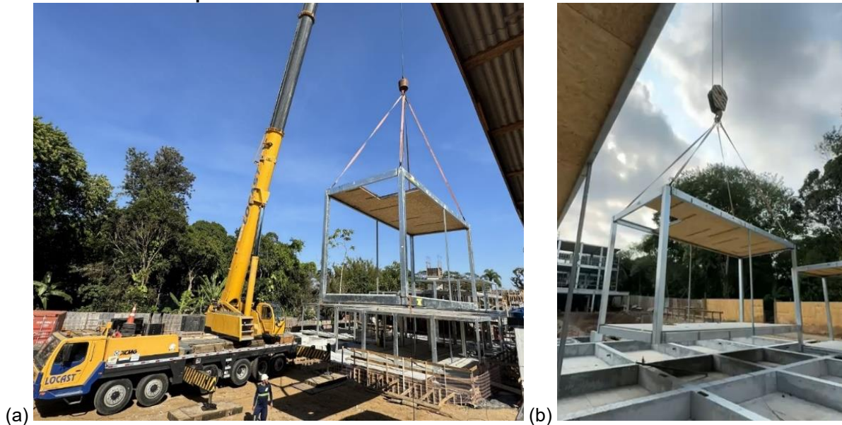
Figura 97 – Recebimento dos módulos no canteiro: (a) movimentação dos módulos; (b) posicionamento dos módulos no canteiro de obras
