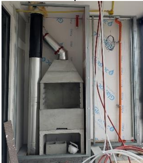
Figura 146 – Instalação da estrutura metálica e posicionamento da churrasqueira pré-moldada
