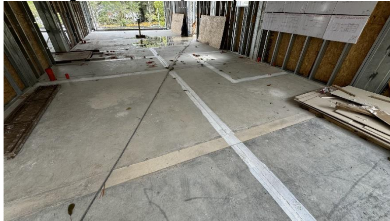
Figura 127 – Marcação das paredes internas
