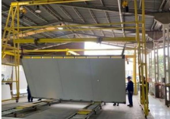
Figura 62 – Giro e posicionamento da cobertura para execução da face superior
