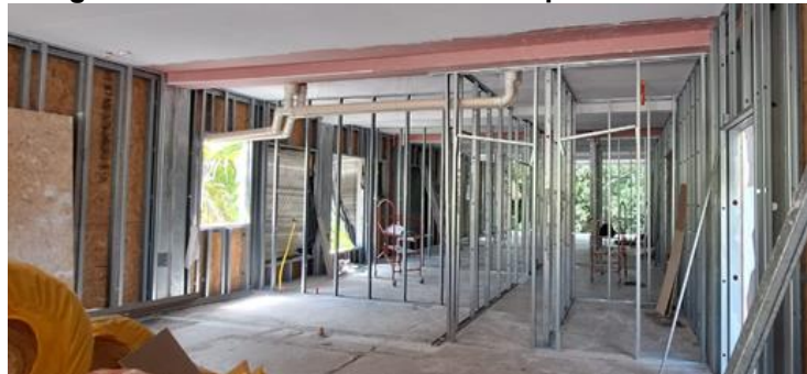
Figura 128 – Estrutura metálica das paredes internas
