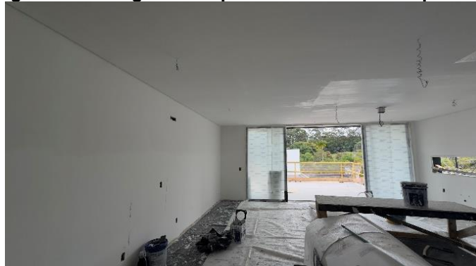
Figura 151 – Segunda etapa: emassamento das paredes
