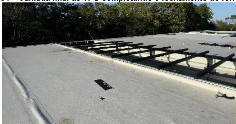
Figura 104 – Camada final de TPO completando o fechamento do forro externo
