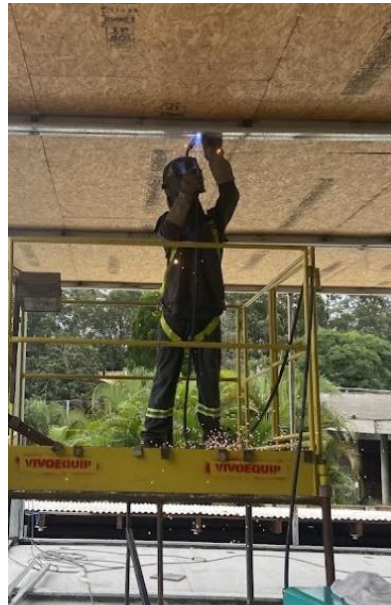
Figura 106 – Processo de solda interna do módulo
