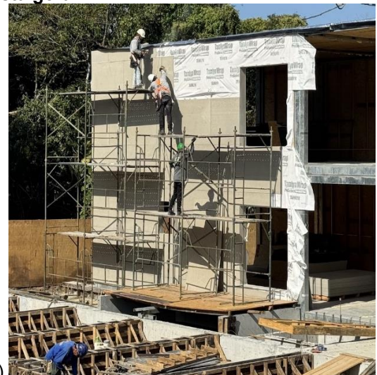
Figura 112 – Aplicação da placa cimentícia nas paredes externas do módulo: (a) vista aproximada; (b) vista geral
