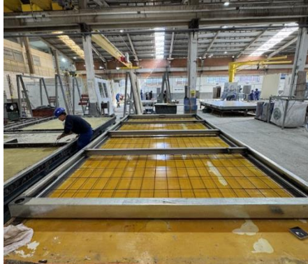
Figura 49 – Estrutura metálica do sistema de piso posicionada na forma
