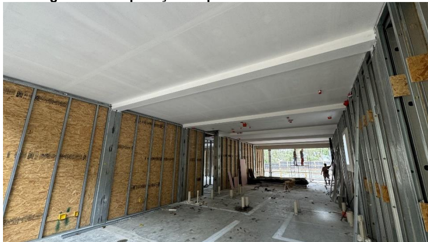
Figura 124 – Aplicação de pintura intumescente no forro
