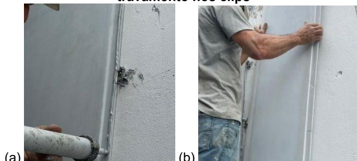
Figura 117 – Terceira etapa de instalação dos painéis GRC: (a) aplicação de PU no verso da placa GRC antes do encaixe; (b) instalação da placa seguinte com encaixe macho-fêmea e travamento nos clips
