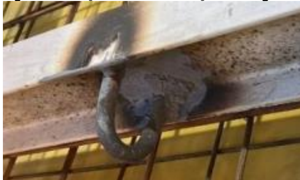
Figura 46 – Alças de movimentação nas vigas I4"
