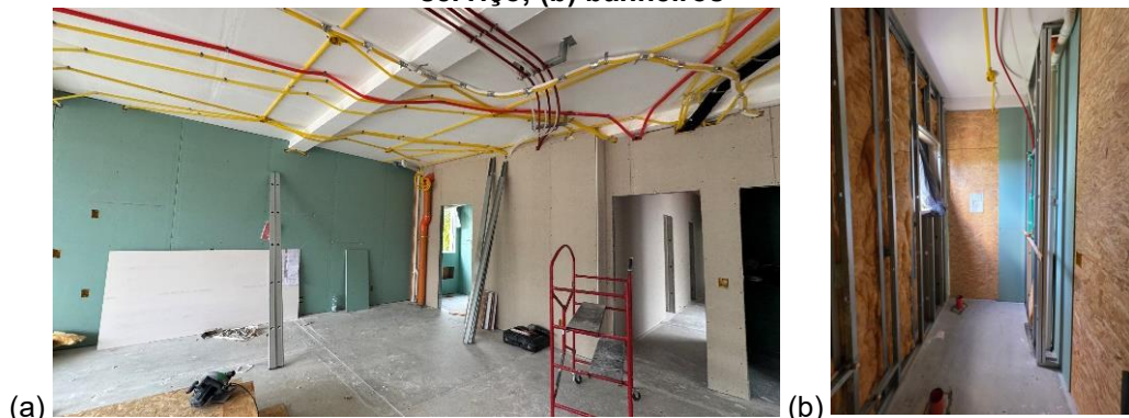
Figura 141 – Fechamento final com placas RU em áreas molhadas: (a) cozinha e área de serviço; (b) banheiros
