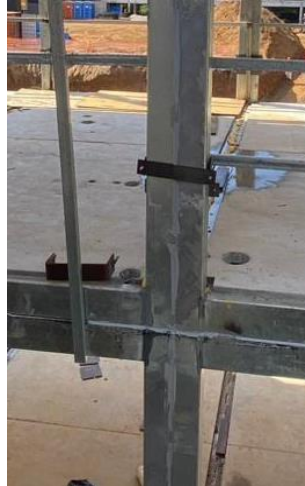
Figura 105 – Vedação das extremidades externas com silicone
