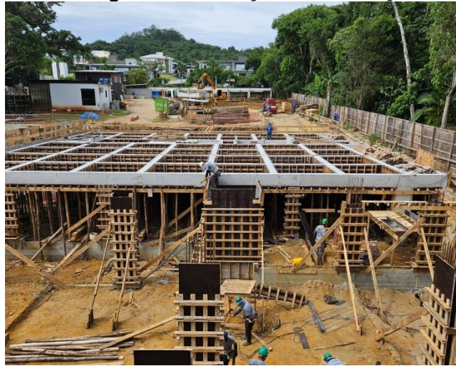
Figura 96 – Vista geral das fundações da edificação: desforma
