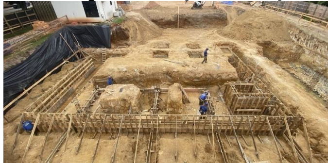
Figura 94 – Vista geral das fundações da edificação: caixaria
