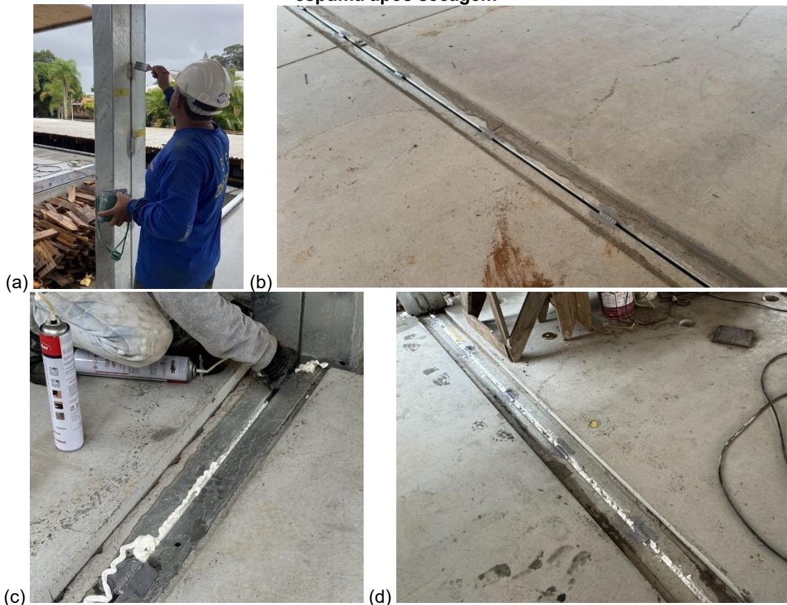
Figura 107 – Tratamento das juntas entre módulos: (a) pintura da solda; (b) junta finalizada após pintura; (c) aplicação de espuma expansiva para vedação; (d) junta finalizada com a espuma após secagem
