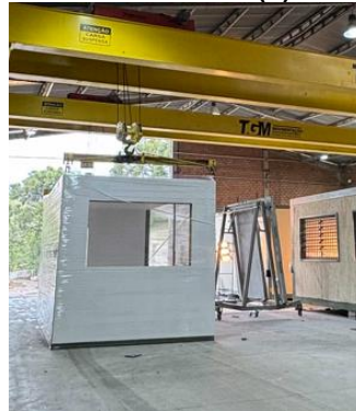
Figura 36 – Acabamento dos módulos (8) - Fábrica Ivoti/ RS (VISIA)
