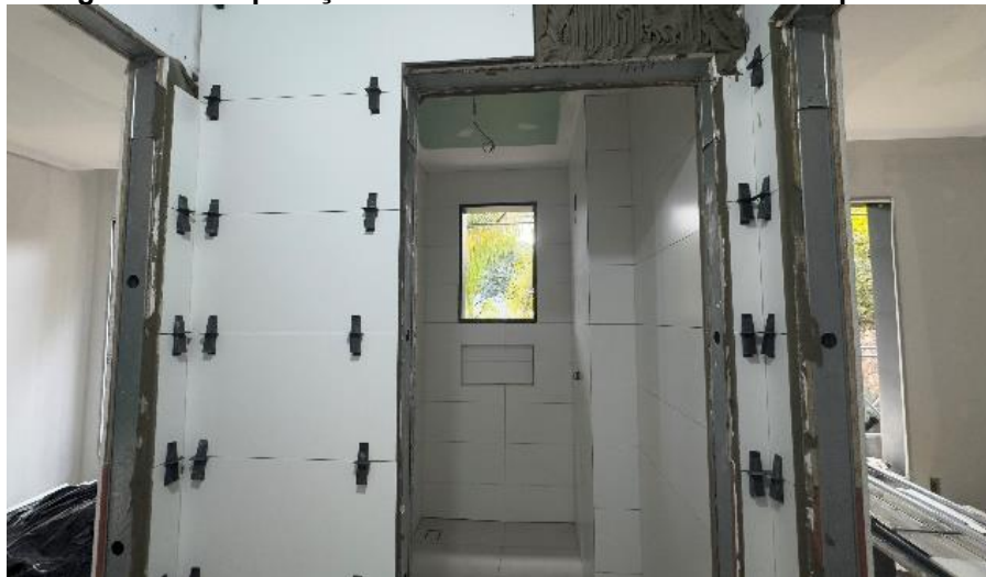
Figura 156 – Aplicação de revestimentos cerâmicos nas paredes
