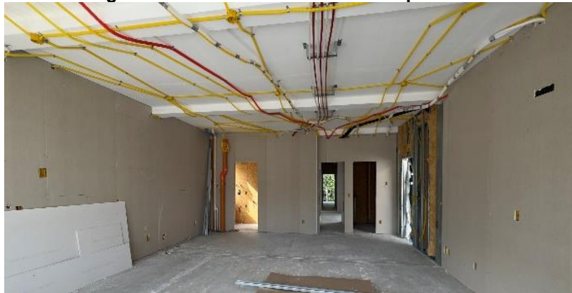
Figura 140 – Fechamento final com placas ST
