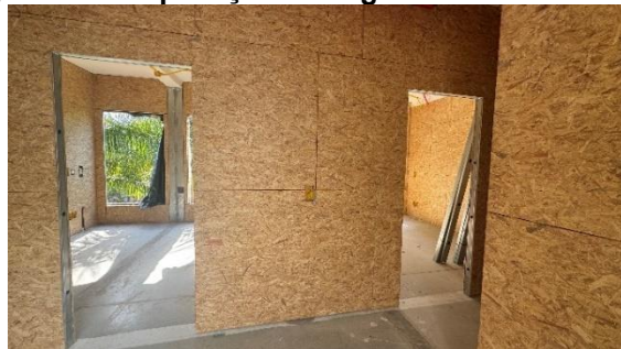
Figura 139 – Aplicação da segunda camada de OSB
