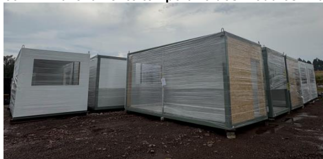
Figura 39 – Armazenamento temporário dos módulos finalizados
