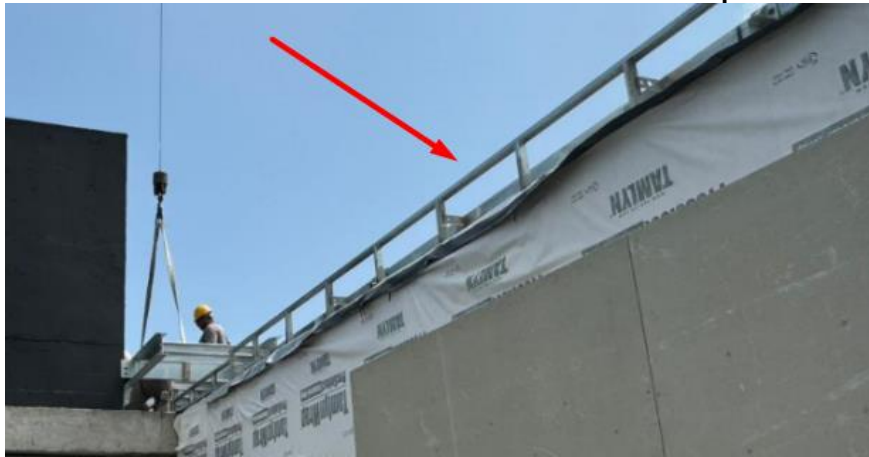
Figura 102 – Estrutura metálica instalada sobre a manta como suporte do fechamento
