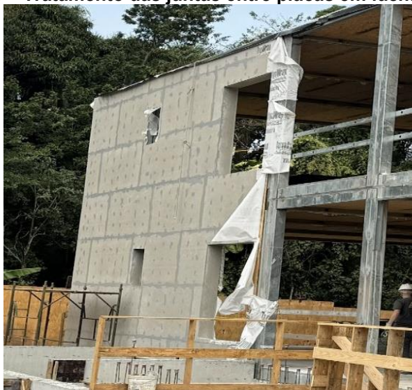
Figura 113 – Tratamento das juntas entre placas em fachada externa
