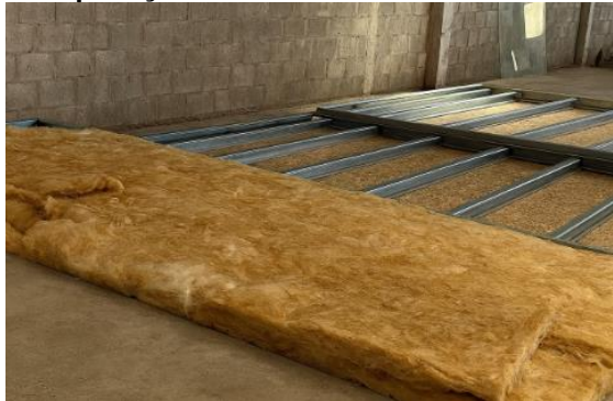
Figura 63 – Aplicação da lã de vidro no sistema de cobertura
