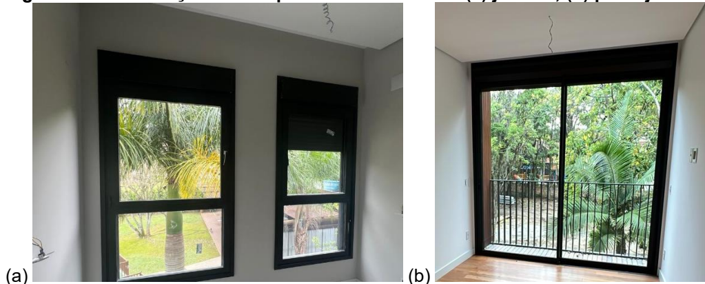
Figura 153 – Instalação das esquadrias de alumínio: (a) janelas; (b) porta janelas
