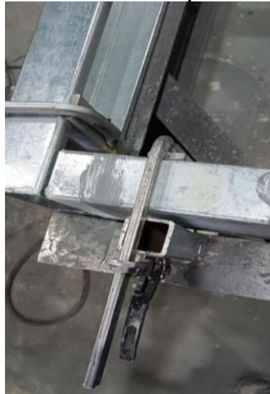
Figura 43 – Nivelamento dos perfis transversais
