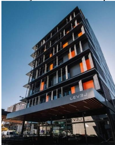
Figura 3 – Edifício Level – construção modular de oito pavimentos em Santa Catarina
