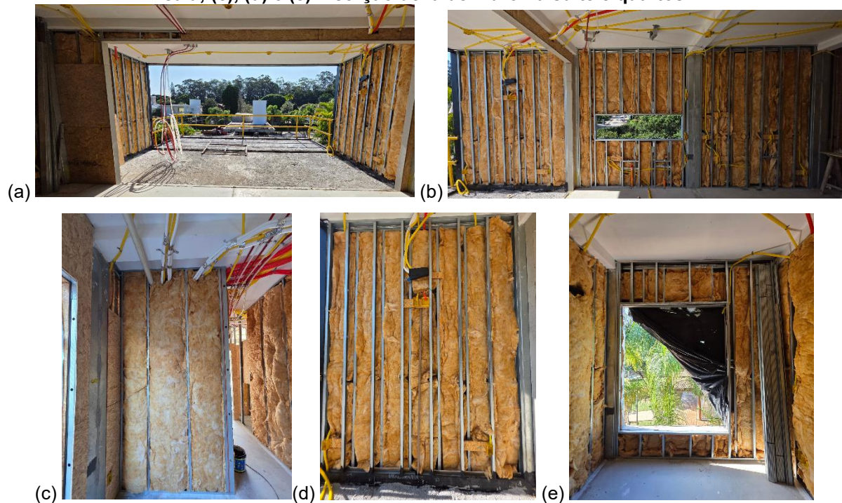
Figura 138 – Aplicação de lã de vidro nas paredes internas: (a) e (b) inserção de lã de vidro na sala; (c), (d) e (e) inserção de lã de vidro na suíte e quartos
