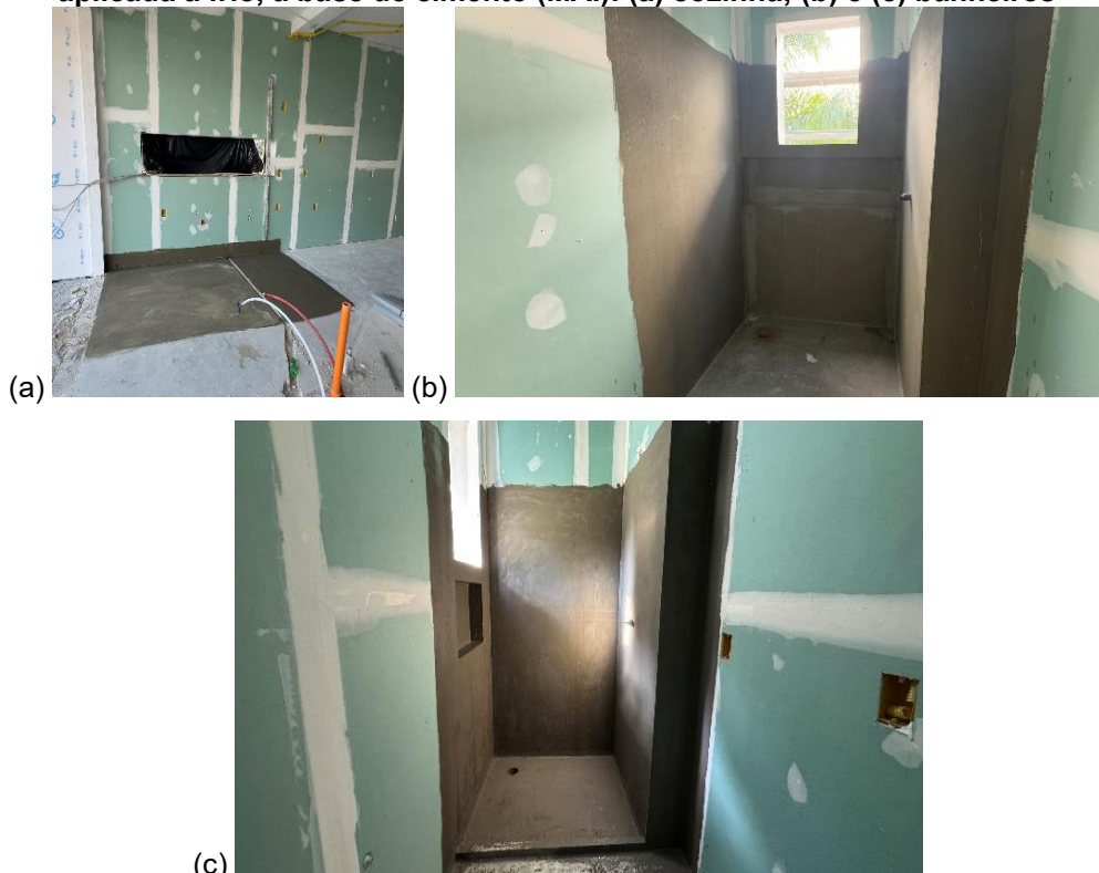
Figura 143 – Execução da impermeabilização nas áreas molhadas com emulsão acrílica aplicada a frio, à base de cimento (MAI): (a) cozinha; (b) e (c) banheiros
