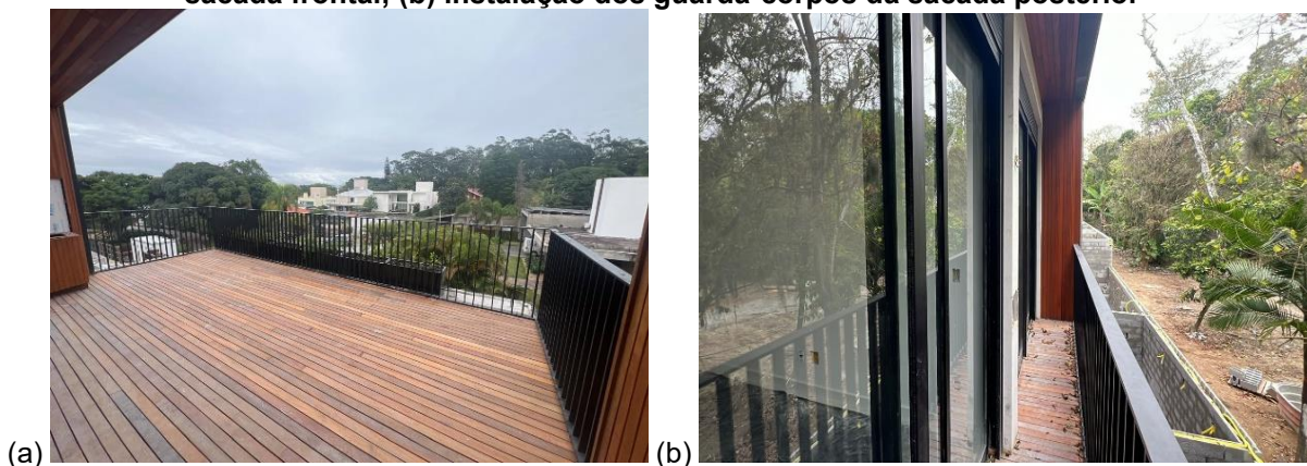
Figura 162 – Instalação do guarda-corpo em alumínio: (a) instalação dos guarda-corpos da sacada frontal; (b) instalação dos guarda-corpos da sacada posterior
