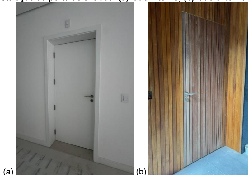
Figura 160 – Instalação da porta de entrada: (a) lado interno; (b) lado externo (hall de acesso)
