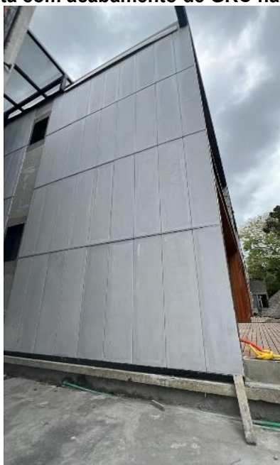
Figura 118 – Fachada completa com acabamento de GRC nas paredes externas do módulo
