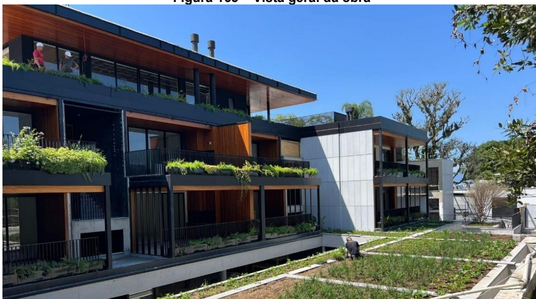
Figura 163 – Vista geral da obra
