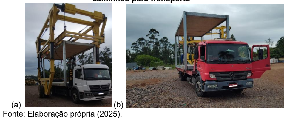
Figura 73 – Movimentação do armazenamento da VISIA para o caminhão que irá fazer deslocamento até o terreno: (a) elevação e alinhamento do módulo; (b) módulo fixado no caminhão para transporte
