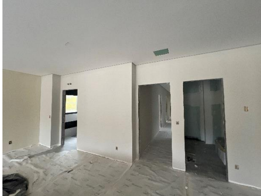
Figura 152 – Terceira etapa: pintura final dos forros e paredes
