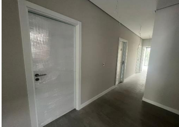
Figura 159 – Montagem das portas internas e instalação dos rodapés
