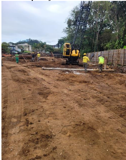
Figura 93 – Preparação e nivelamento do terreno
