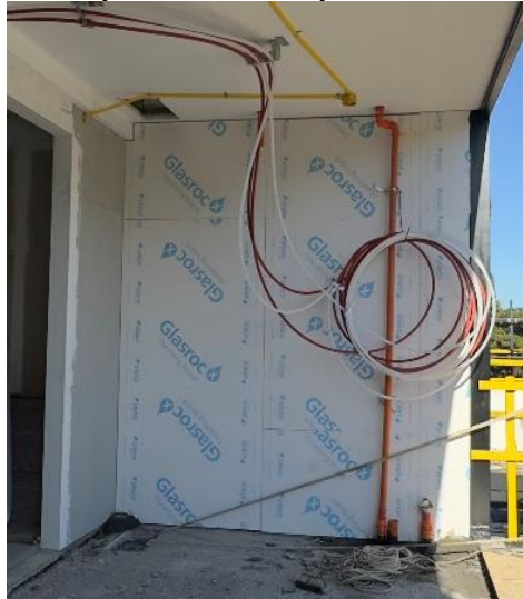
Figura 130 – Primeiro chapeamento com placa OSB nas paredes da sacada
