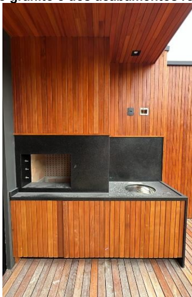
Figura 149 – Instalação do granito e dos acabamentos refratários da churrasqueira
