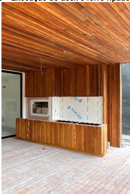
Figura 148 – Execução do deck e forro ripado na sacada
