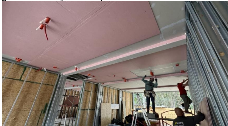
Figura 122 – Fixação da chapa RF sobre a camada base do forro
