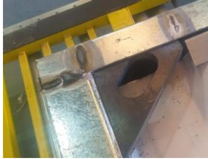
Figura 64 – Alças de içamento fixadas na estrutura da cobertura
