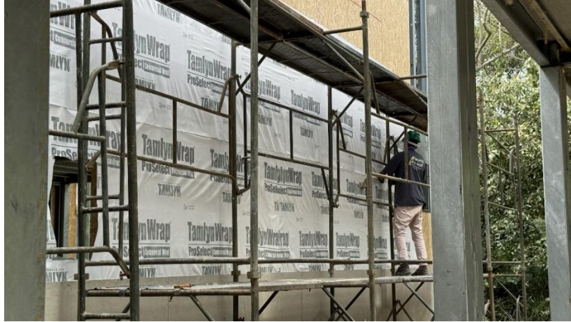
Figura 111 – Aplicação da membrana nas paredes externas do módulo
