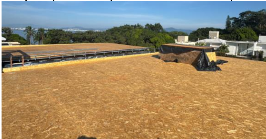
Figura 103 – Fixação do painel de OSB para resistência mecânica e suporte de acabamento
