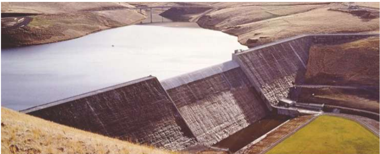
Figura 2: Barragem de Gravidade.
