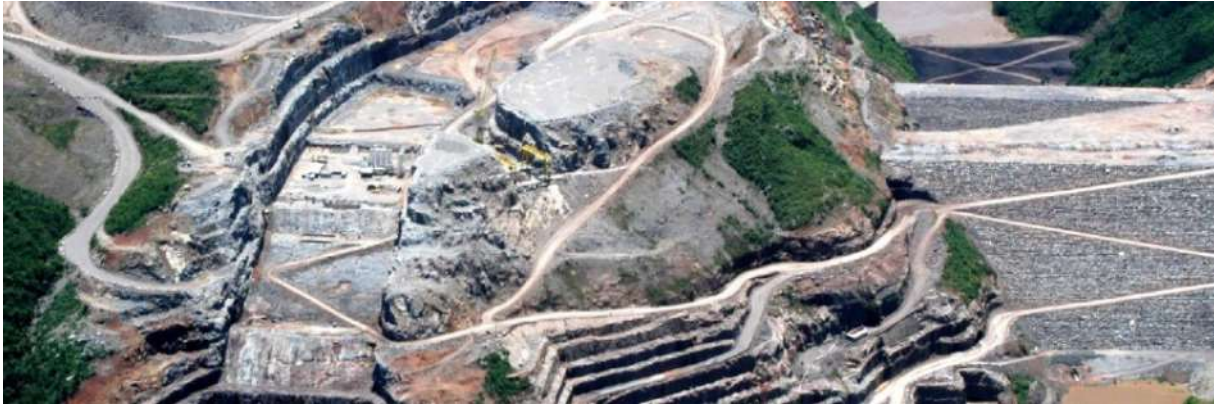
Figura 3: Barragem de Enrocamento
