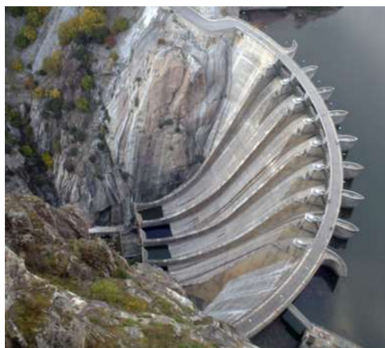
Figura 5: Barragem em Arco.
