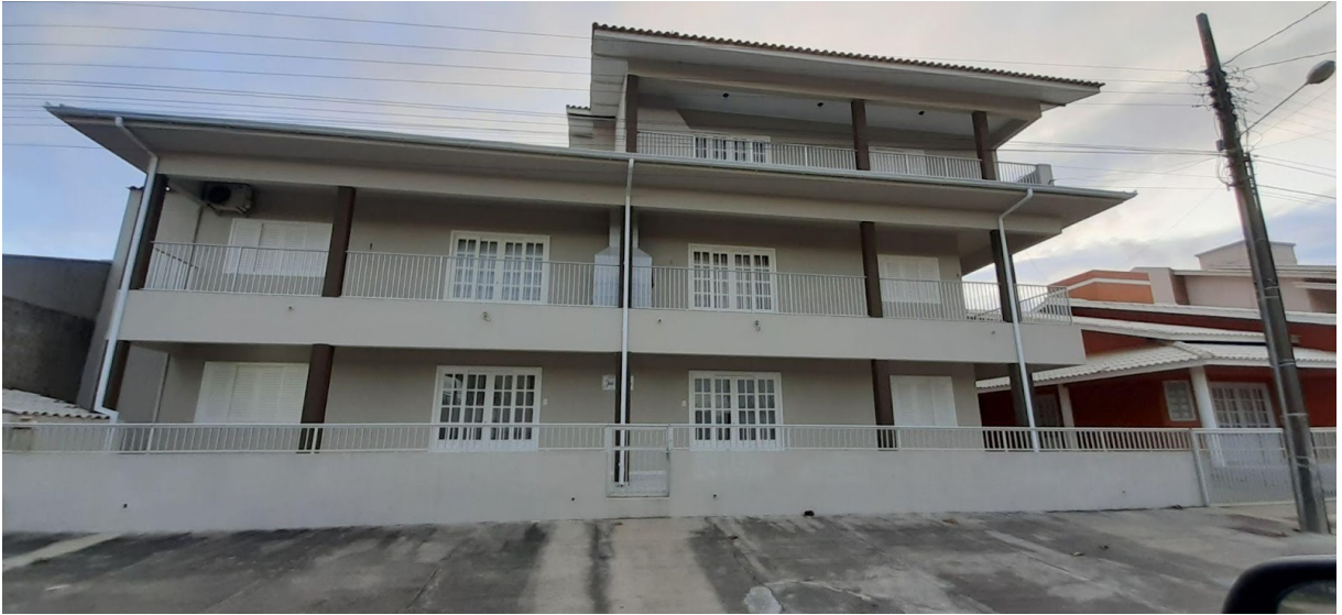
Figura 06 – Edifício de três pavimentos
