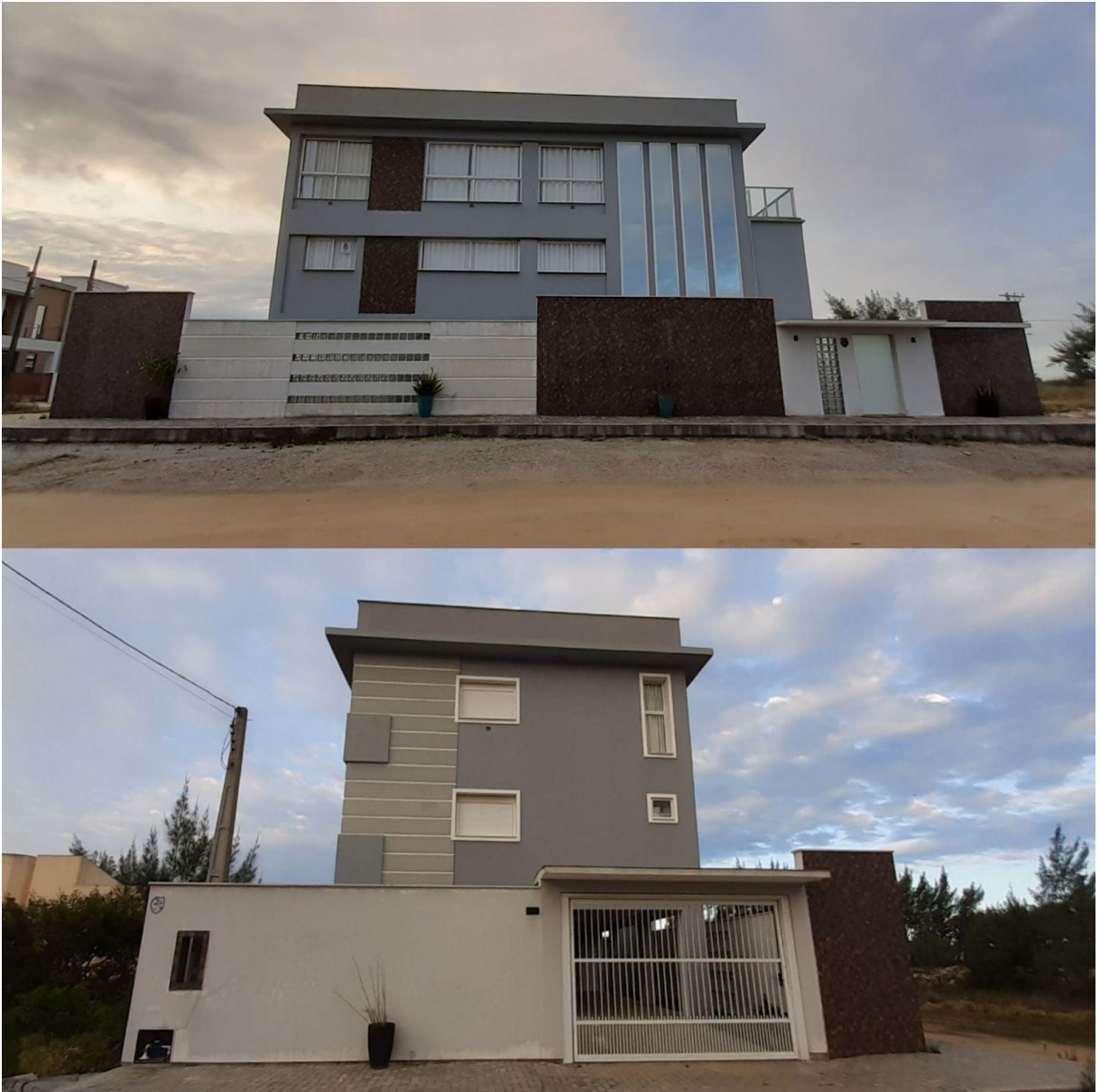
Figura 05 – Edifício com garagem em pilotis
