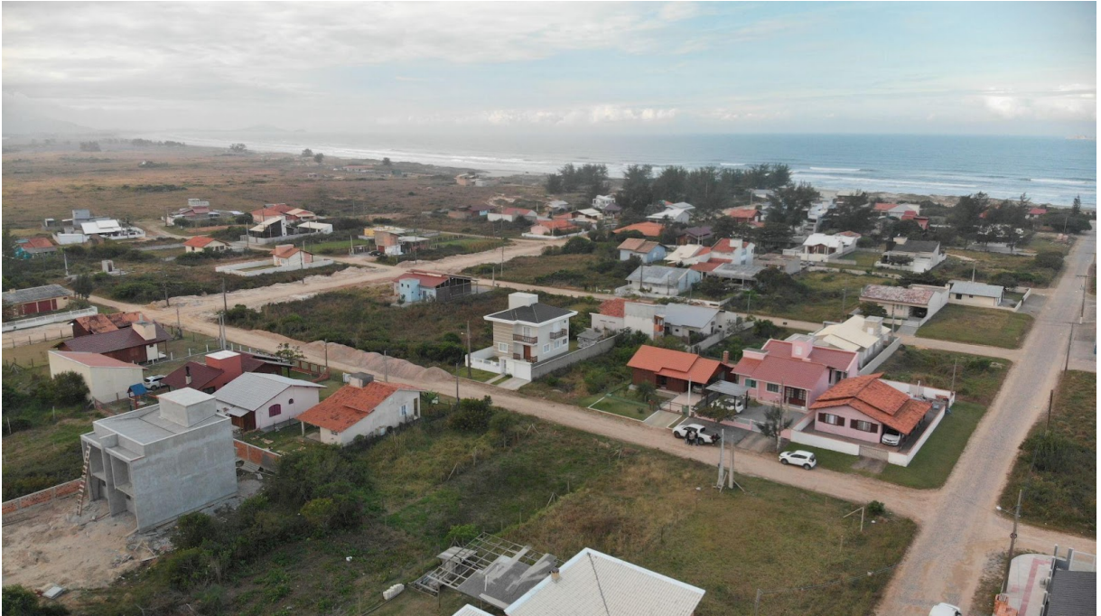
Figura 08 – Vista nordeste do bairro Itapirubá
