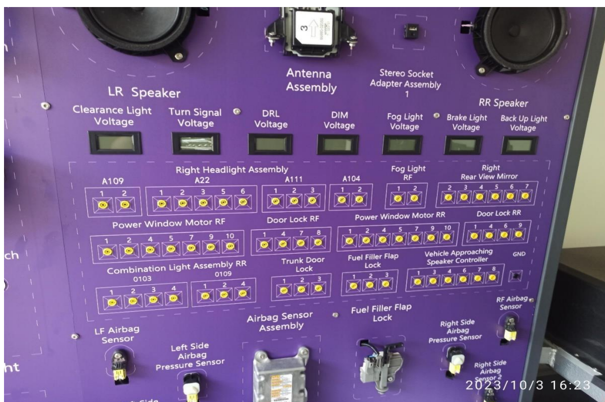
Figura 29 - Foto do painel de controle da bancada dos painéis (wall)
