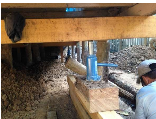
Figura 41 - Macaco hidráulico troca barrotes
