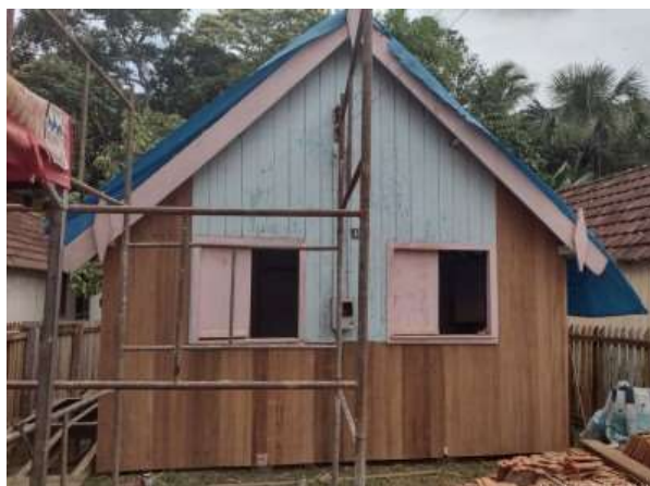
Figura 49 - Troca de madeira na fachada
