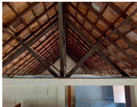
Estrutura da cobertura Fonte: Da autora (2022)
