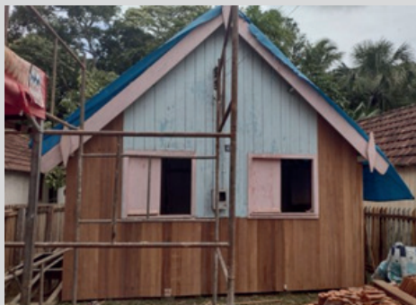
Troca das tábuas da parede frontal Fonte: CSZ Engenharia (2015)
