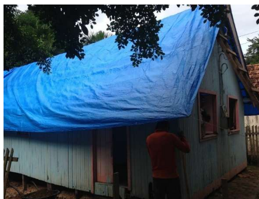
Figura 40 - Retirada da cobertura
