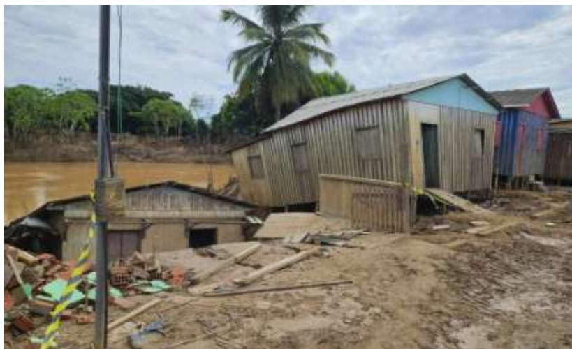
Figura 112 - Residência na Rua Major Salinas, impactada pela inundação de 2024
