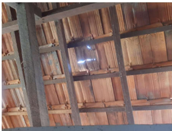
Figura 65 - Telha quebrada
