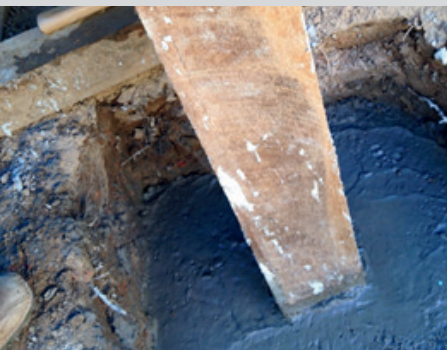
Blocos de concreto nas fundações Fonte: CSZ Engenharia (2015)
