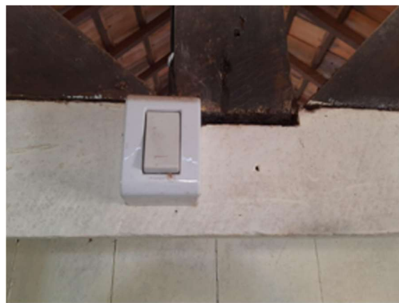
Figura 66 - Flexão na linha da tesoura causando espaçamento
