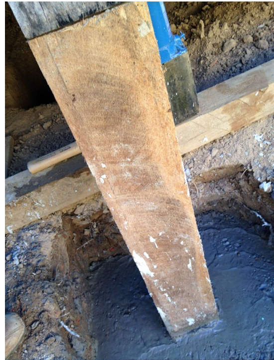
Figura 44 - Blocos de concreto
