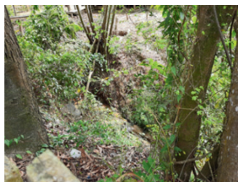
Erosão nos fundos do terreno Fonte: Da autora (2020)
