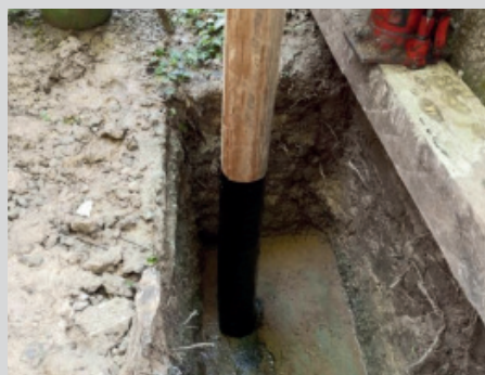
Impermeabilização do barroto Fonte: Saraiva Engenharia (2023)
