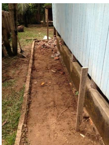
Figura 37 - Baldrame de alvenaria
