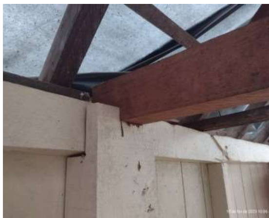
Figura 50 - Manuten o linha da tesoura
