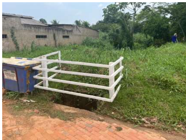
Figura 110 - Proteção da boca de lobo localizada acima da manilha (2024)
