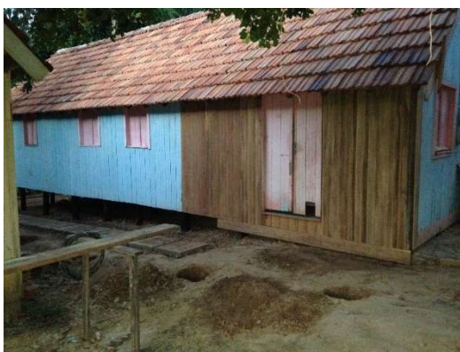
Figura 39 - Troca de madeira na parede
