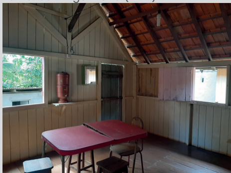
Parede original onde respingou o sangue Fonte: CSZ Engenharia (2015)
