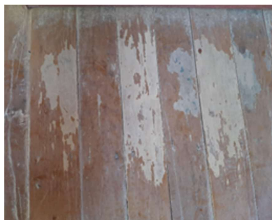
Figura 80 - Piso desgastado
