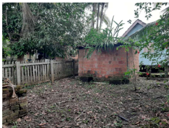
Figura 88 - Edícula - fachada posterior
