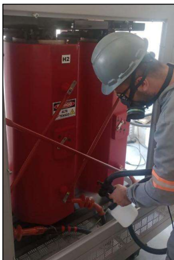
Figura 80 – Aplicação de desengraxante dielétrico por pulverização
