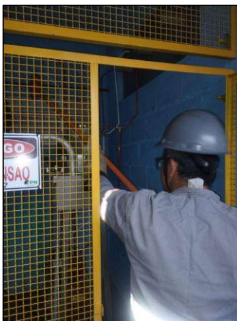
Figura 42 – Teste de detecção de tensão realizado pela equipe na entrada de energia
