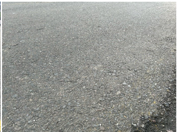
Figura 19: Desgaste.
