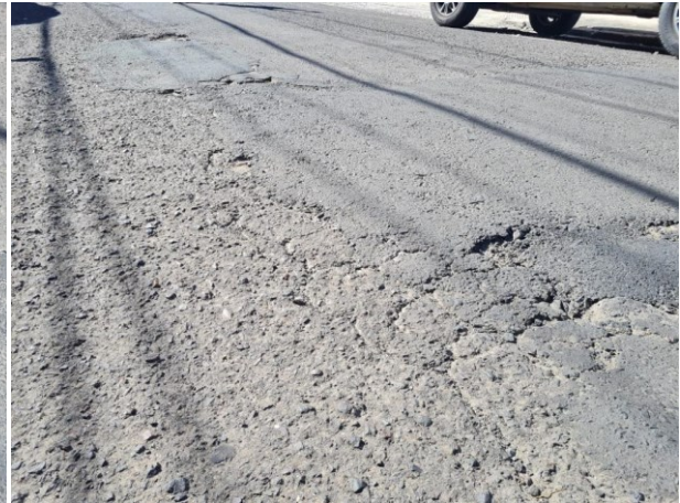
Figura 15: Desgaste.
