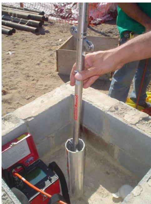
Figura 34: Instalação e leitura de inclinômetro
