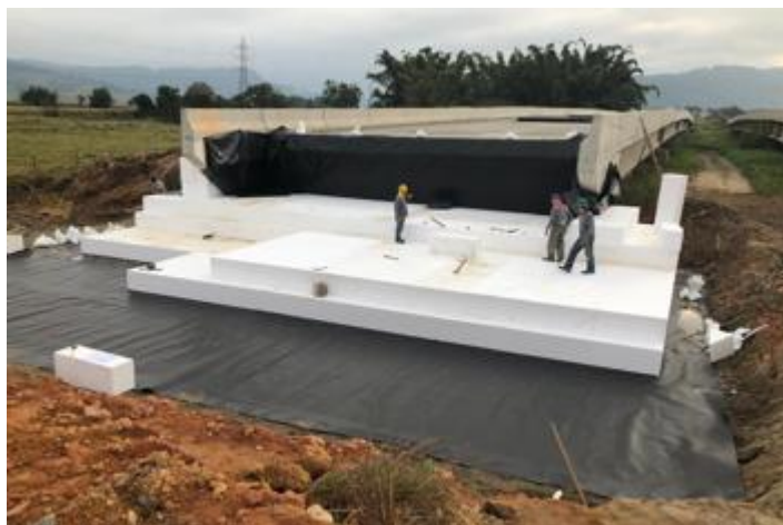
Figura 26: Execução de aterro leve sobre solos moles
