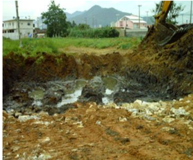
Figura 22: Remoção de camada de solos moles
