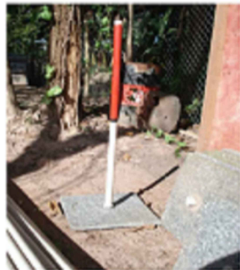
(a) nivelada, antes de instalação -apresenta o 1º segmento de tubo
