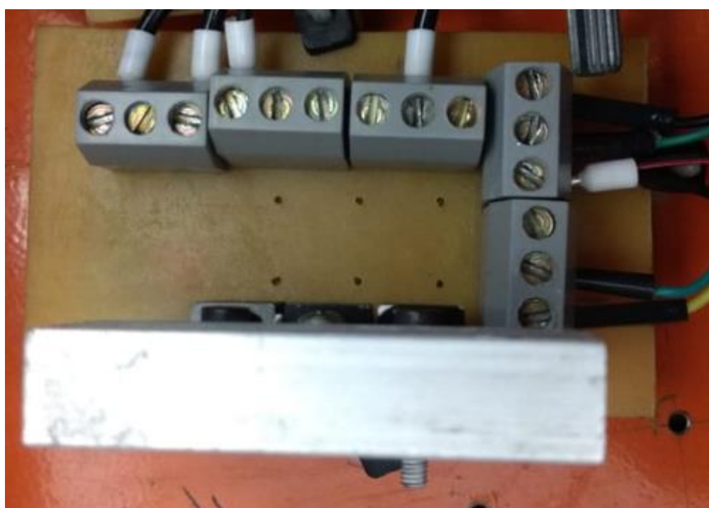
Figura 12 – Placa de potência em funcionamento
