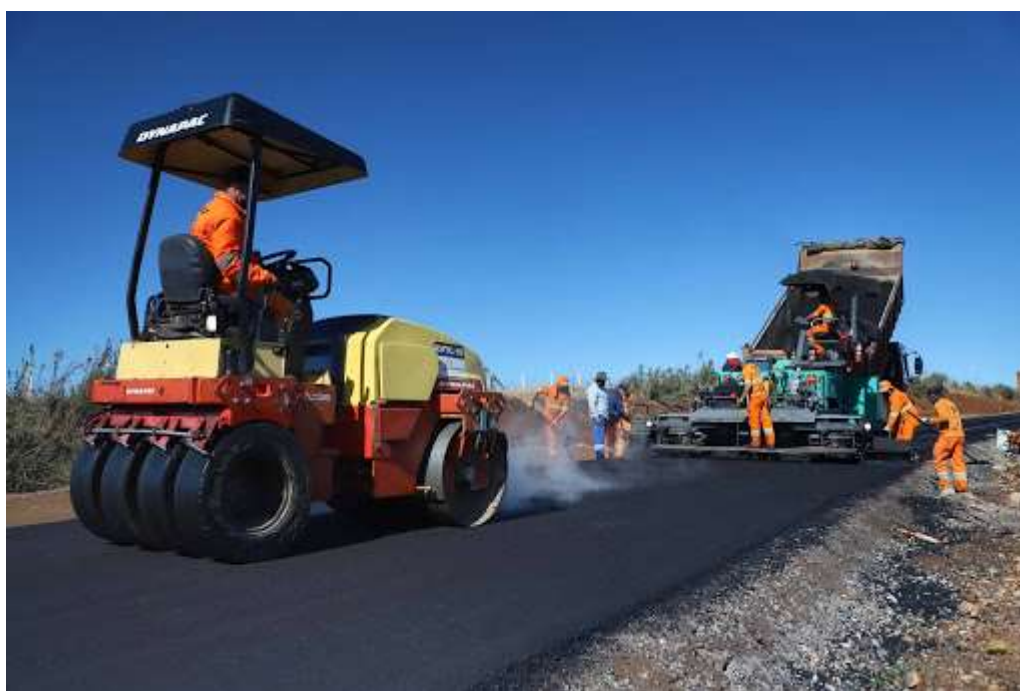
Figura 4 - Lançamento e compactação de CBUQ
